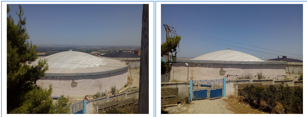
Figure 5 : Réservoir de la ville d'El Affroun (photos originales).
