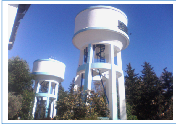
Figure 4 : Deux réservoirs de l'hôpital Frantz Fanon de Blida (photo originale)
