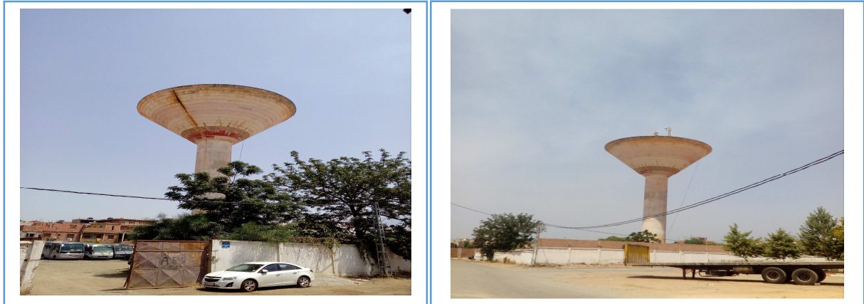
Figure 6 : Réservoir de la ville de Mouzaïa (Photos originales).
