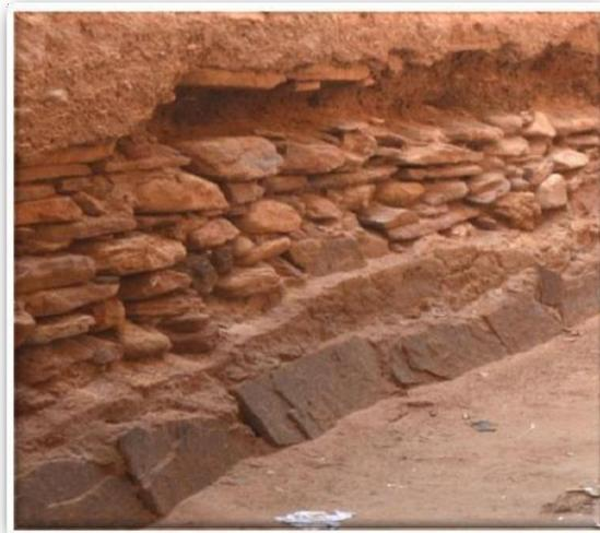
*Figure II-31 : Mur de soutènement d'une maison[43]*
