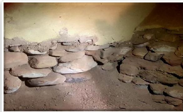
Figure II- 28 : La pierre utilisée dans la construction des murs
