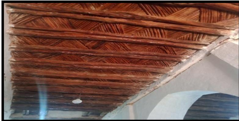
*Figure II- 30 :EL defla utilisée dans le plancher de la mosquée (Auteur,)*
