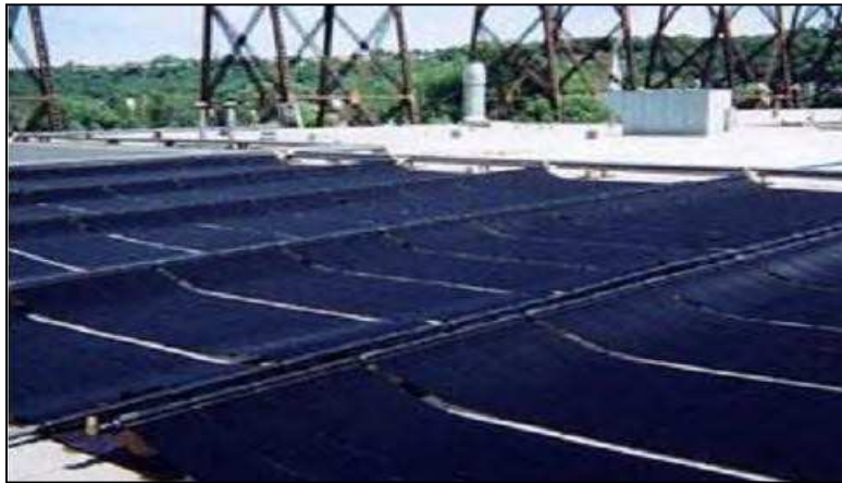
Figure I-11 : capteur solaire plan non vitré [18]
