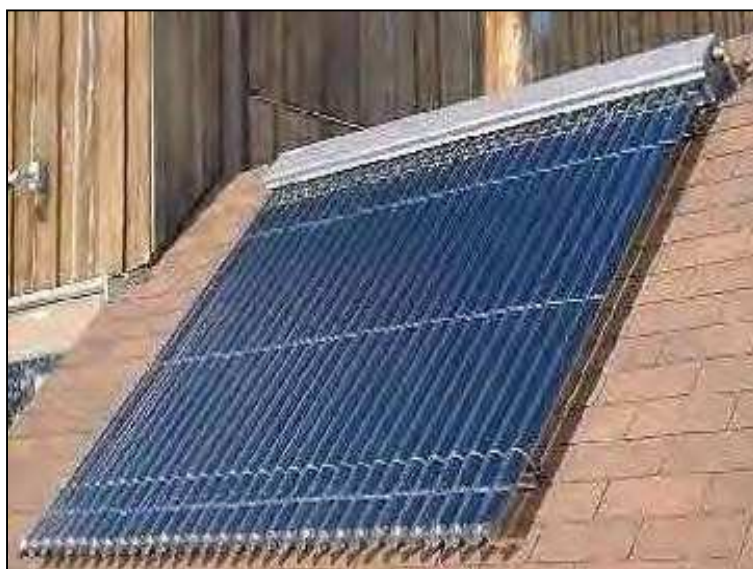
Figure I-13 : Capteur solaire a tube sous vide [19]
