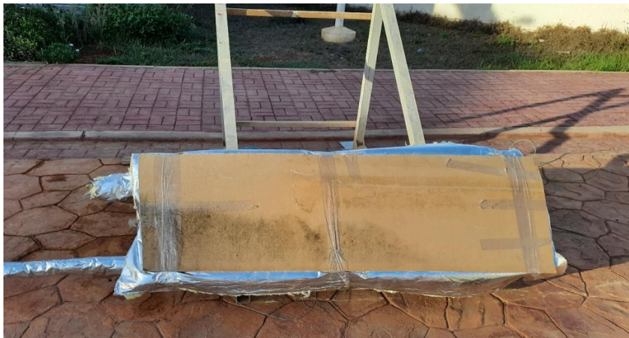
Figure 3. 34 Pose d'une couche isolante en laine de verre sur la face vitrée du chauffe-eau solaire
