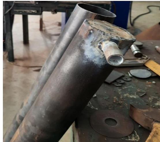
Figure 3. 16 Soudage des tubes de jonction
