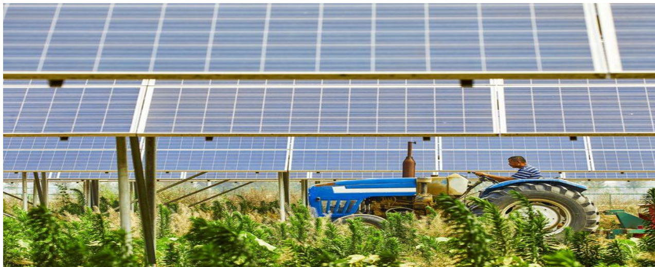
Figure II.2 : Système photovoltaïque appliquée dans une ferme.
