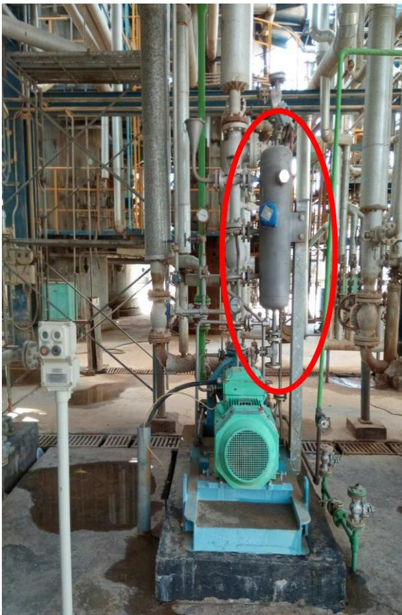
**Figure (23) Pompe avec ballon de protection**
