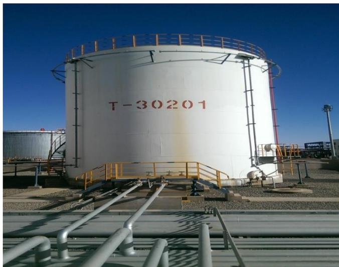
**Figure (7) Bac de stockage de Naphta**
