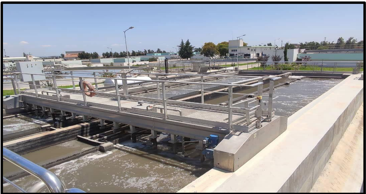
Figure II-4 : prétraitement de la STEP [44].
