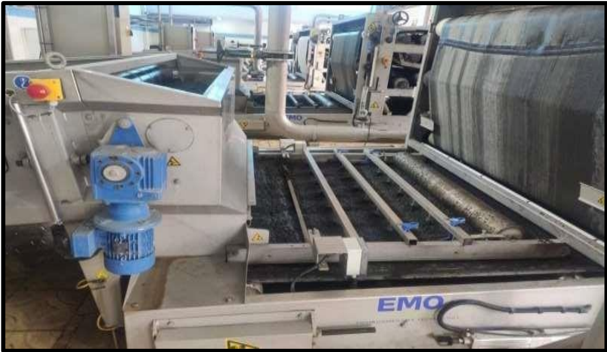
Figure II-17 : Usine de déshydratation.
