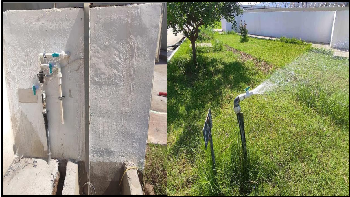
Figure III-4 : Vannes alimentée par les eaux épurées [originale].
