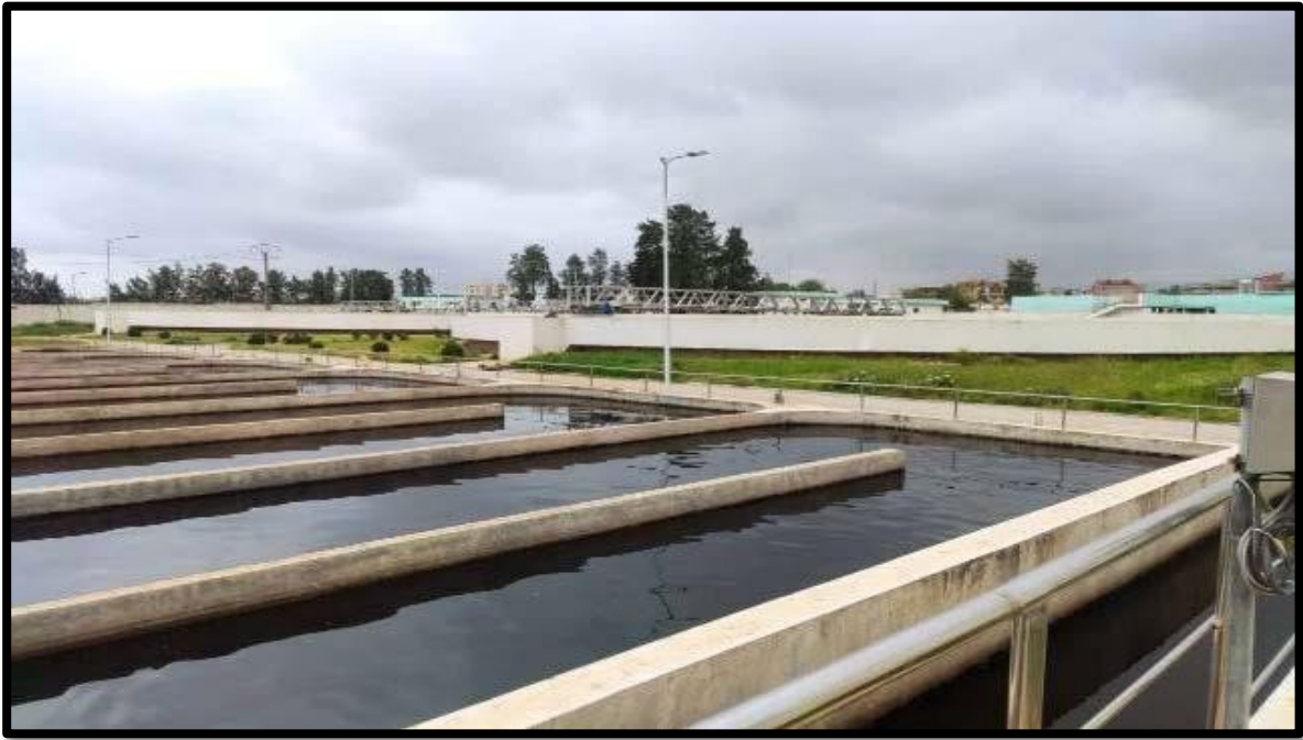
Figure II-10 : Bassin de désinfection a chicanes [44].
