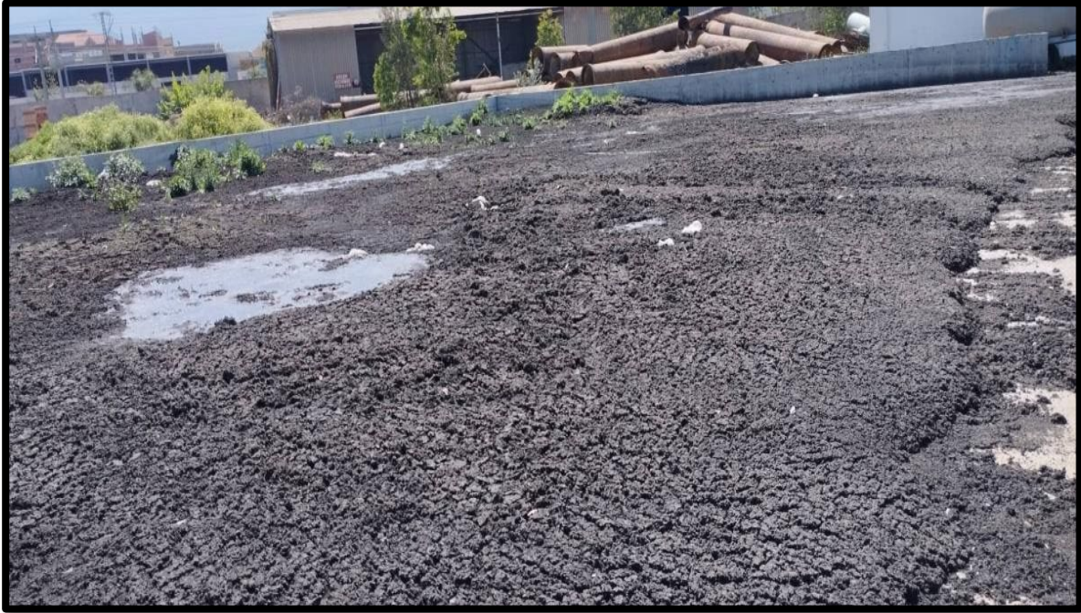
Figure II-18 : Zone de stockage des boues déshydratées.
