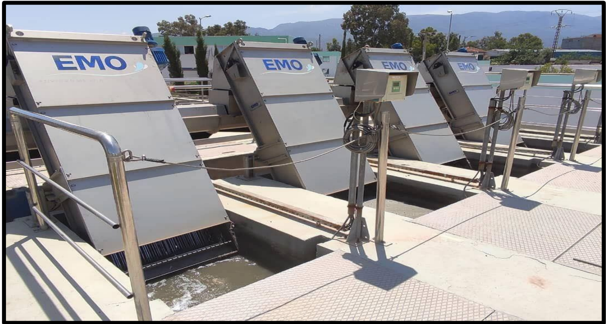
Figure II-5 : Dégrilleur automatique fin [44].
