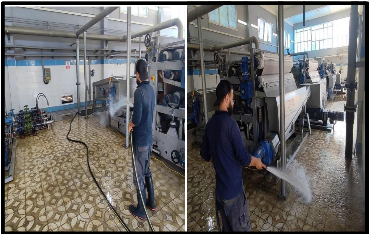
Figure III-1 : Nettoyage d'usine de déshydratation [originale].
