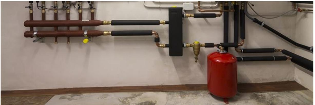
**Figure 4 :** Un vase d'expansion dans un circuit de chauffage
