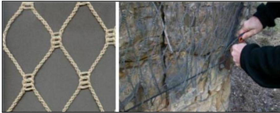
Figure II.11 : Modèle et mise en place du géo-filet [12]
