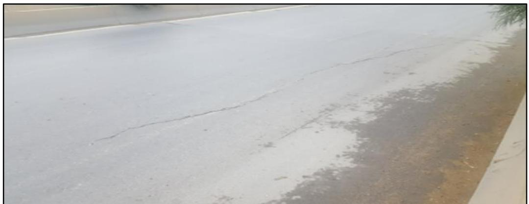
Figure IV.6 : Fissure longitudinale apparente sur la rive droite
