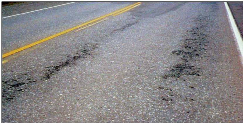
Figure I.16 : Arrachement sus forme de plumage
