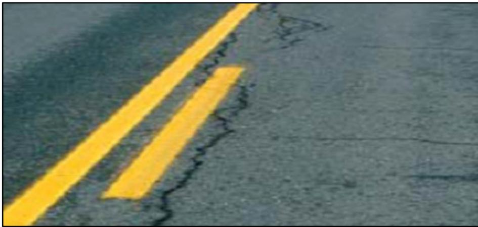
Figure I.4: Fissure longitudinale dans une chaussée [01]
