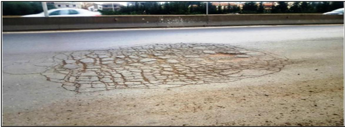
Figure IV.9 : Faiénçage localisé accompagné par des arrachements
