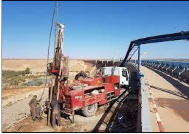
Figure III.2 : Sondage carotté au droit d'une chaussée
