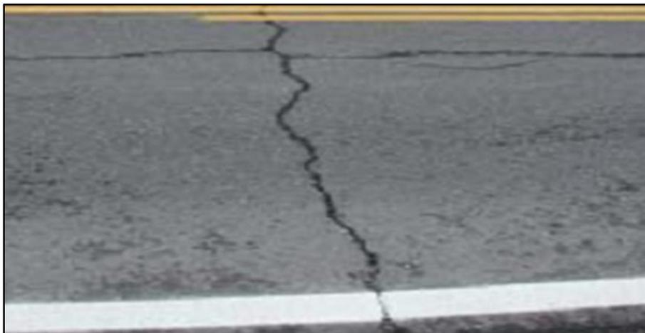
Figure I.3: Fissure transversale au niveau d'une chaussée [01]
