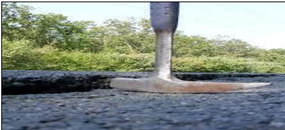
Figure I. 11: Exemple d'un gonflement d'une chaussée
