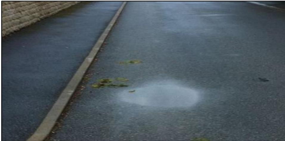
Figure I. 10: Flache sous forme de tassement
