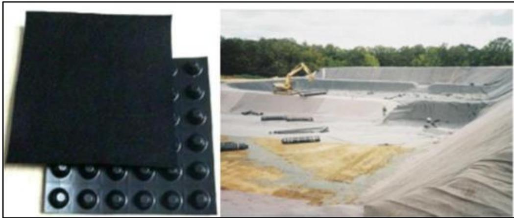
Figure II.13 :Géomembrane –forme et mise en place [12]
