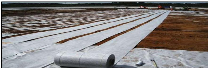
Figure I.19: Application des nappes géo-synthétiques
