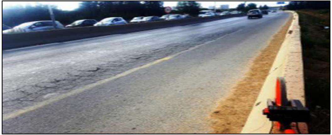
Figure IV.4 Faiénçage à mailles fines avec affaissement
