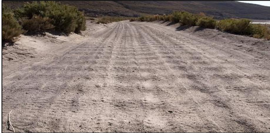
Figure I.12: Tôle ondulée apparente
