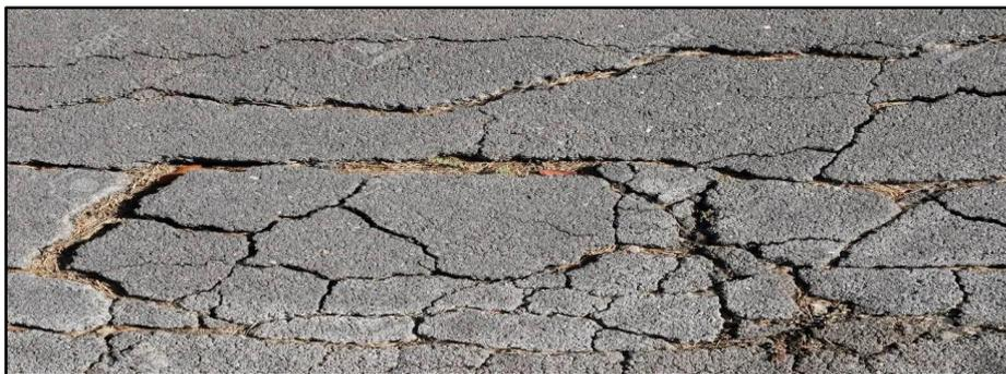
Figure I.7: Tracés D'épaufure dans une chaussée
