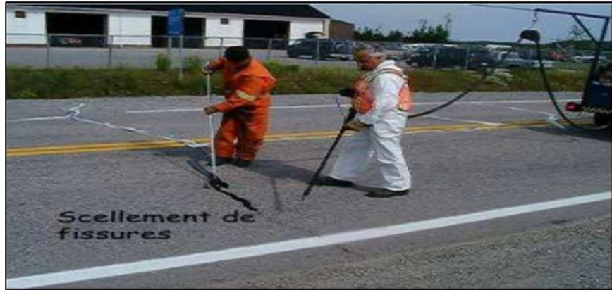
Figure I.18: Scellement de fissures[3]
