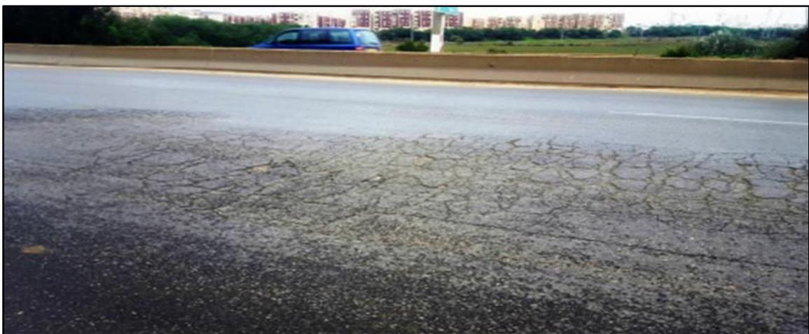
Figure IV.8 Faïençage généralisé sur la voie de droite
