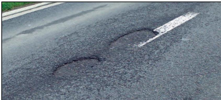
Figure I.13: Désenrobage sur chaussée
