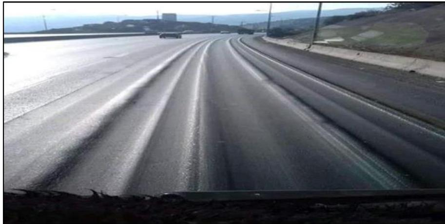
Figure I.8: Le phénomène d'orniérage sur un tronçon d'autoroute
