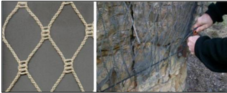
Figure II.11 : Modèle et mise en place du géo-filet [12]
