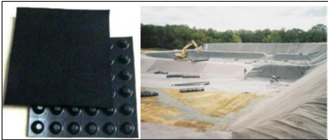
Figure II.13 :Géomembrane –forme et mise en place [12]
