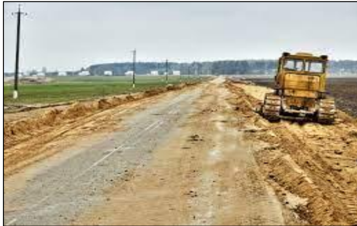
Figure III.1 :Reconnaissance du sol pour assise routière
