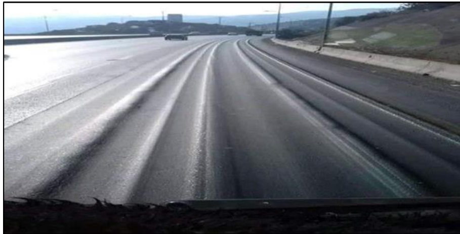
Figure I.8: Le phénomène d'orniérage sur un tronçon d'autoroute
