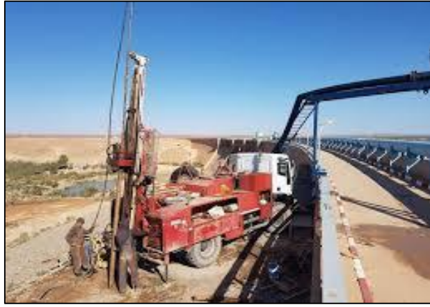
Figure III.2 : Sondage carotté au droit d'une chaussée
