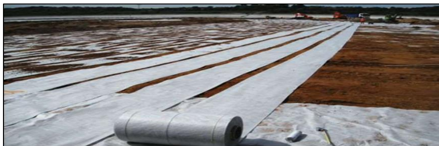
Figure I.19: Application des nappes géo-synthétiques
