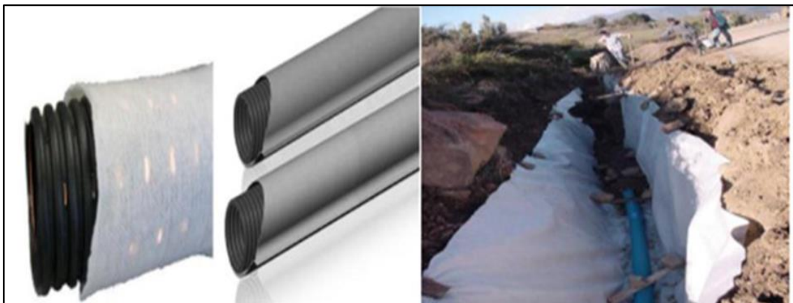
Figure II.9 : Forme et mise en œuvre des géo-tuyaux [12]
