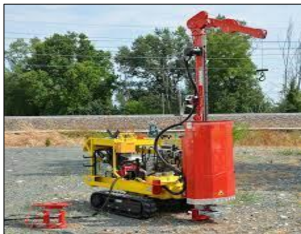
Figure III.3 Vue de foreuse géotechnique au niveau du site
