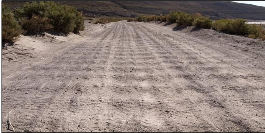
Figure I.12: Tôle ondulée apparente
