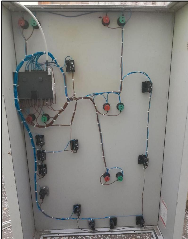
**Figure 4.20 : Branchement des E/S de l'automate avec la partie opérative**
