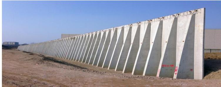
**Figure I.25 :** schéma de mur en paroi préfabriquée
