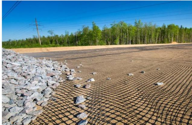
**Figure I.32 :** Renforcement par ajout de Matériaux
