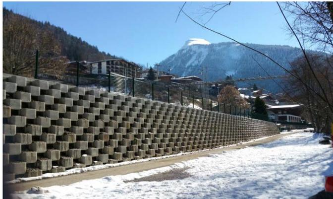
**Figure I.30 :** mur en paroi modulaire
