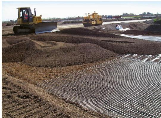
**Figure I.2:** Remblai allégé aux granulats d'argile expansée
