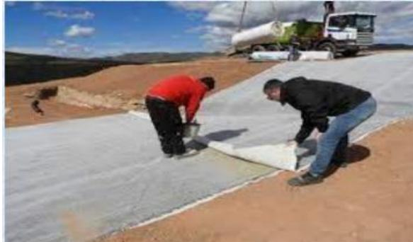
Figure I.43 : Exemple du Pose de nappe de géo-synthétique
