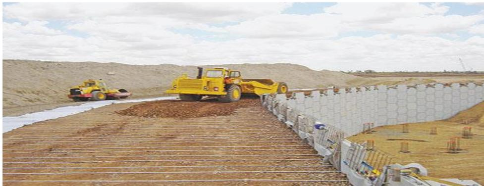
**Figure I.26 :** mur en terre armé
