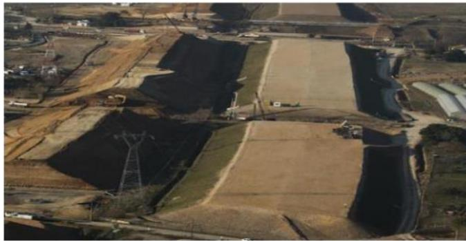
**Figure I.3 :** Remblai de grande hauteur
