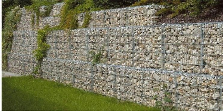
**Figure I.29:** mur en gabion
