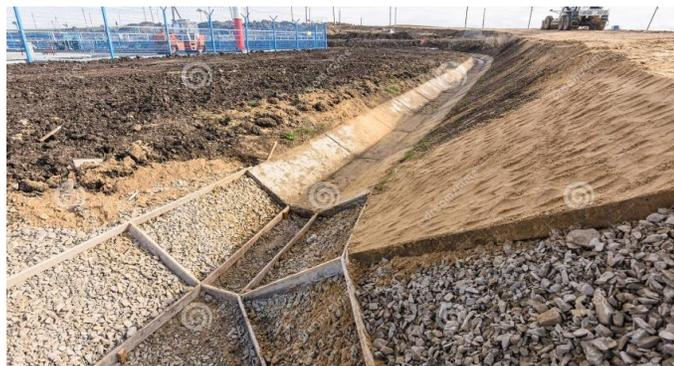
**Figure I.36 :** Renforcement par drainage
