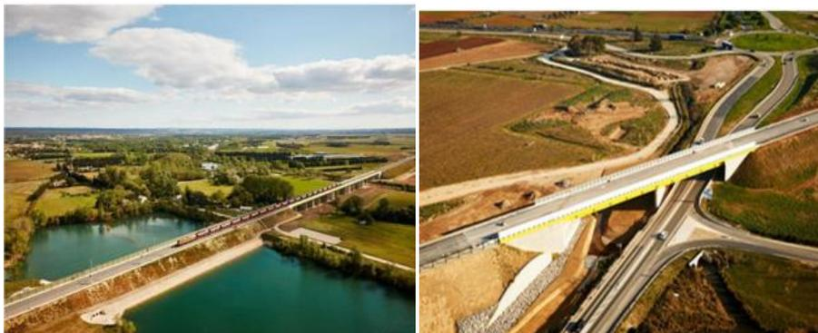
**Figure I.1:** Types de Remblai (ferroviaire, routier)
