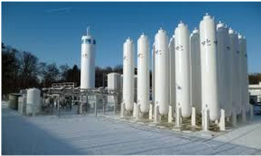
Figure 2.14 : stockage d'hydrogène sous forme liquide. [63]
