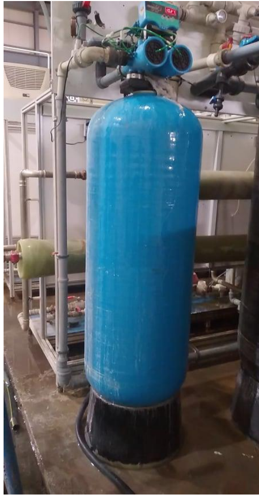
Figure II.2 : filtre à sable
