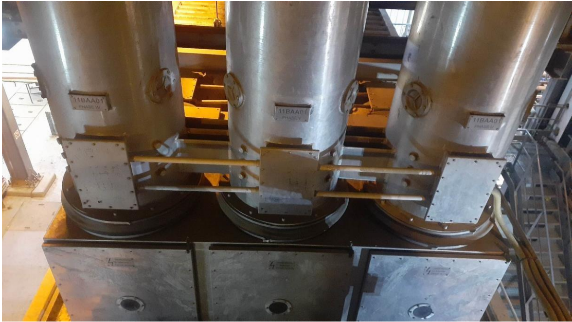
Figure 1.9 : Les bornes de l'alternateur WY21Z-092RR. [4]
