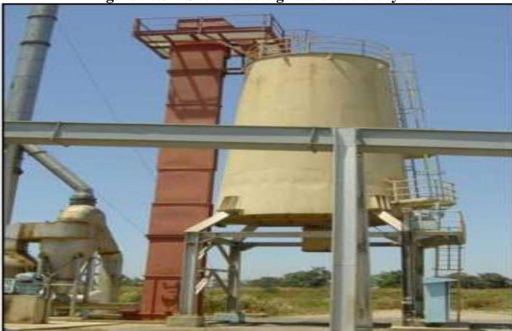
**Figure IV.38: Silo de stockage des boues séchées**
