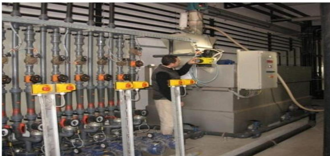
Figure V.24 : Les pompes pour polymère et le local de fabrication de polymère
