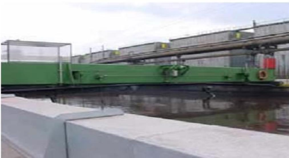
Figure II-6 : Décanteur rectangulaire
