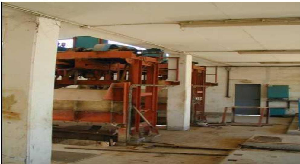
**Figure IV.4 : Dégrillage**
