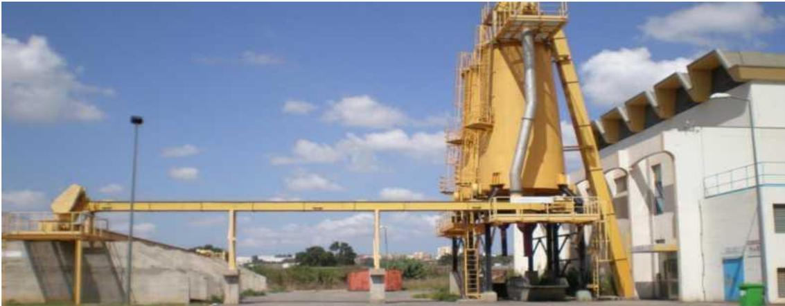
**Figure V.25 : Les silos des boues déshydratées**
