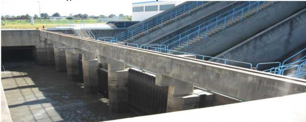
**Figure V.2 : Emplacement des grilles grossières**
