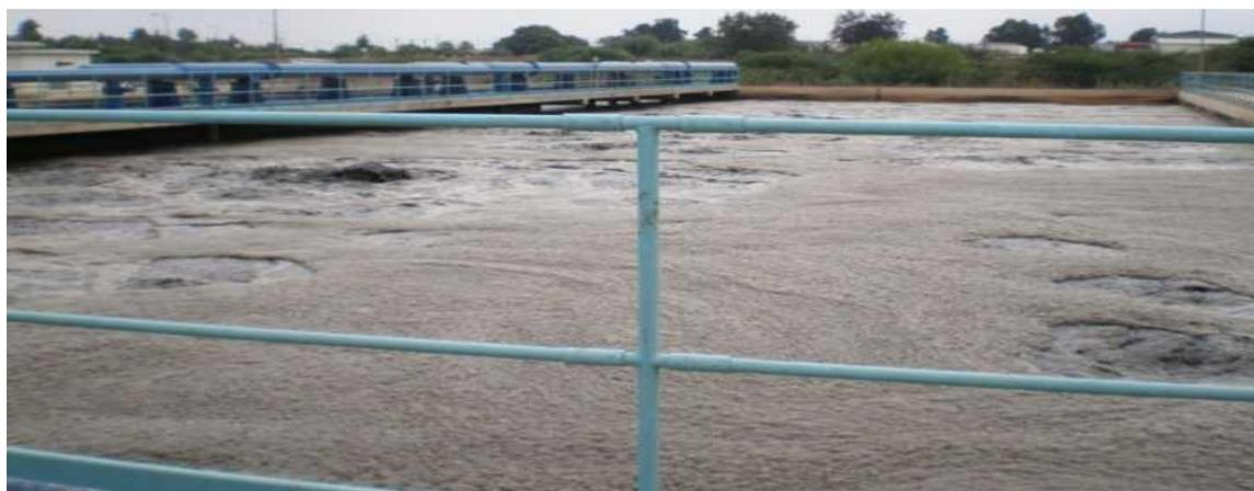
Figure V-9 : Bassin d'aération fonctionnel
