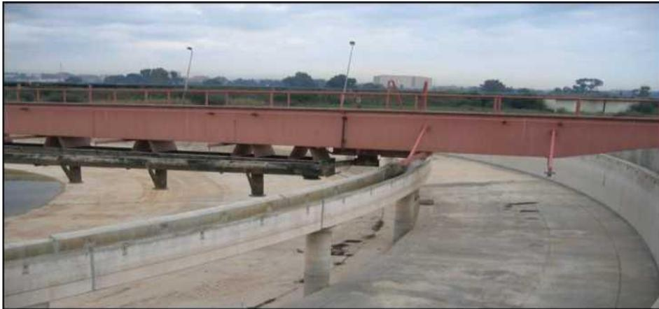
**Figure IV.9 : Décanteur secondaire**
