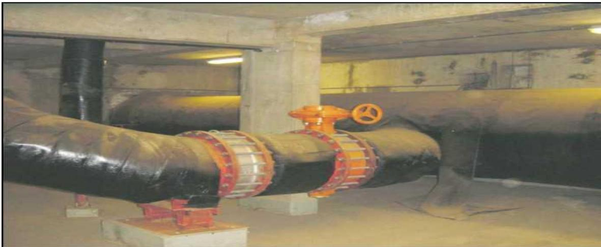
**Figure IV.26: Calorifugeage des collecteurs d'air dans la centrale de production d'air**
