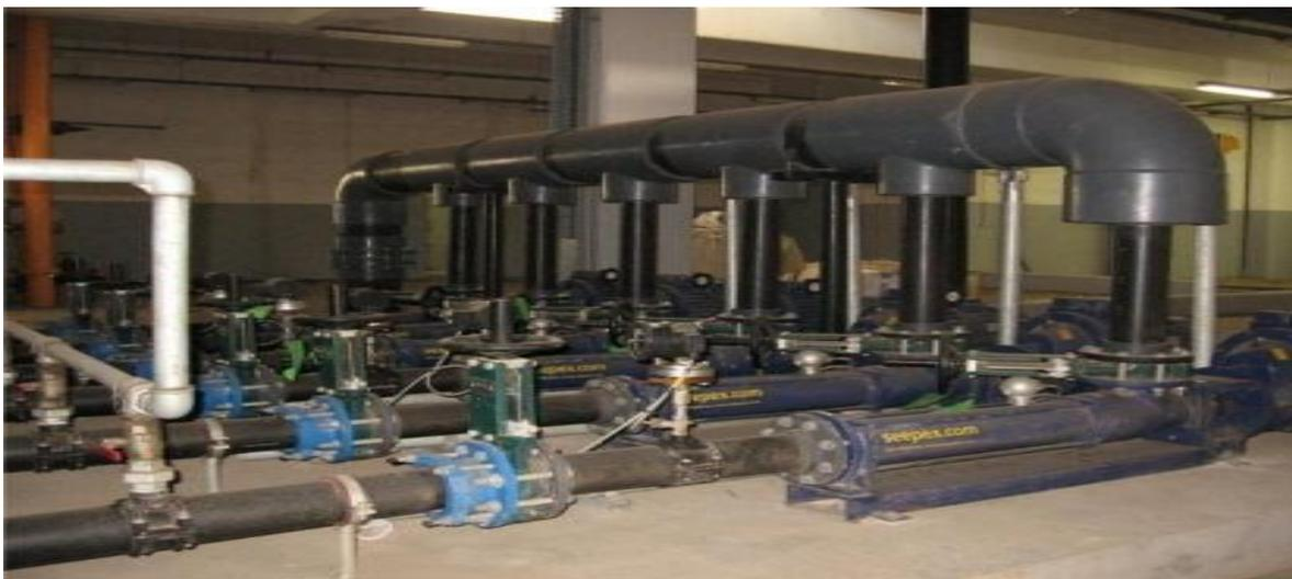
Figure V.23 : Les pompes à boues
