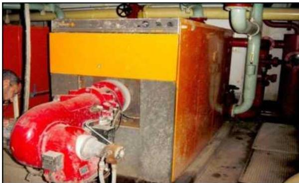
**Figure IV.33: Chaudière avec brûleur**
