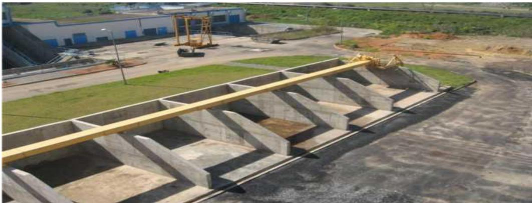
**Figure V.26 : Déshydratation - stockage des boues (bac de stockage)**
