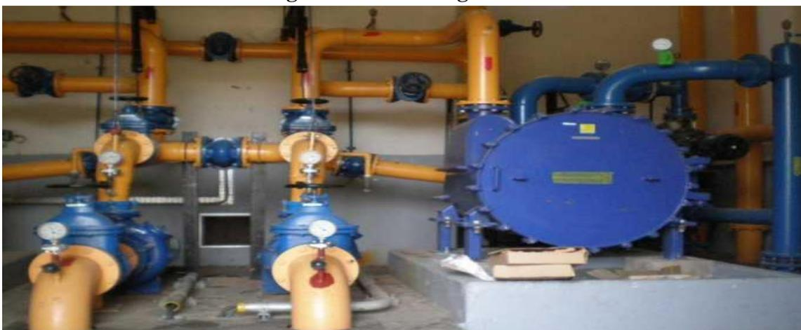
**Figure V.18 : Les nouveaux échangeurs thermiques**
