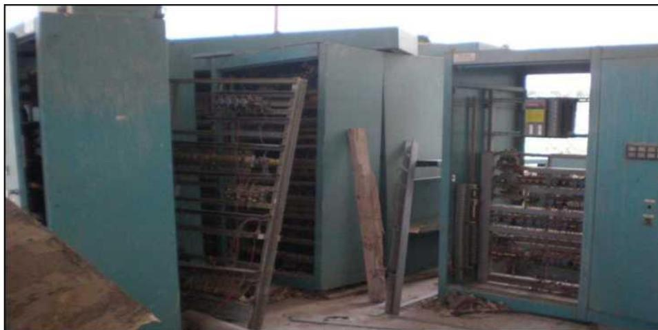
**Figure IV.41: Détérioration des cages électriques**
