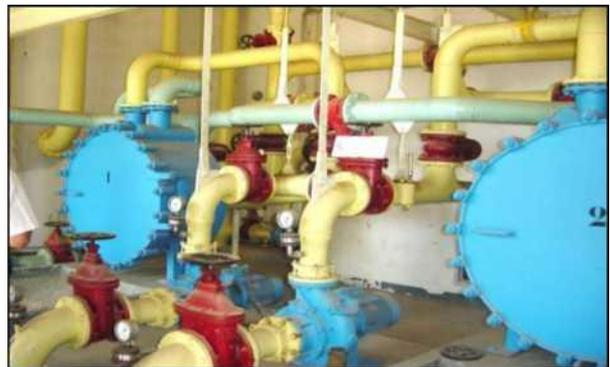
**Figure IV.34: Échangeurs thermiques**
