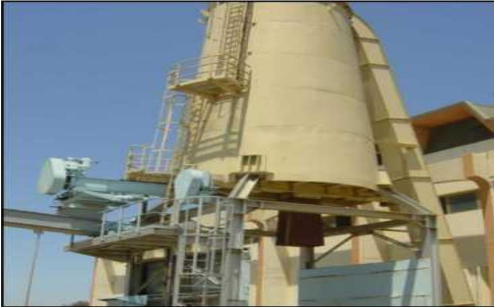
**Figure IV.37: Silo de stockage des boues déshydraté**
