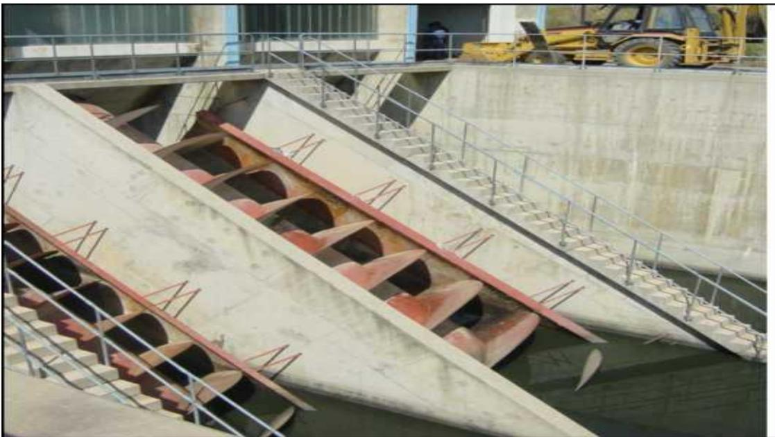
**Figure IV.15: les vis d'Archimède**
