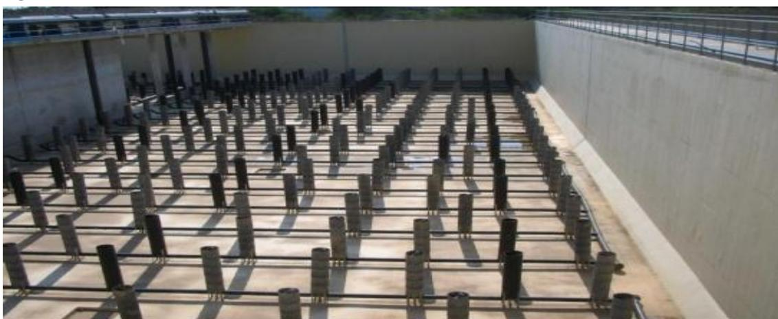
Figure V-8 : Les diffuseurs d'air
