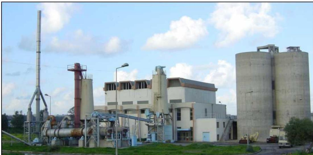
**Figure IV.40: Bâtiment de déshydratation mécanique, silos à chaux (à droite), séchage thermique et silos de stockage des boues déshydratées / séchées**
