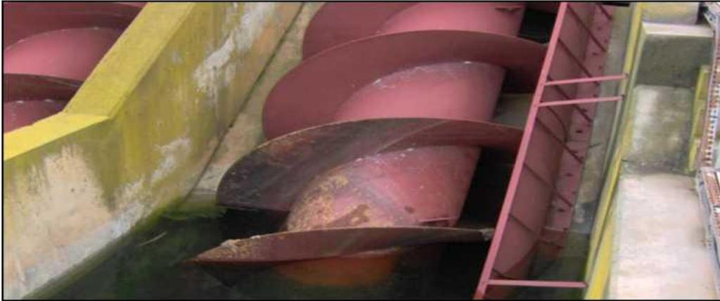
**Figure IV.30: État de l'équipement de recirculation des boues**
