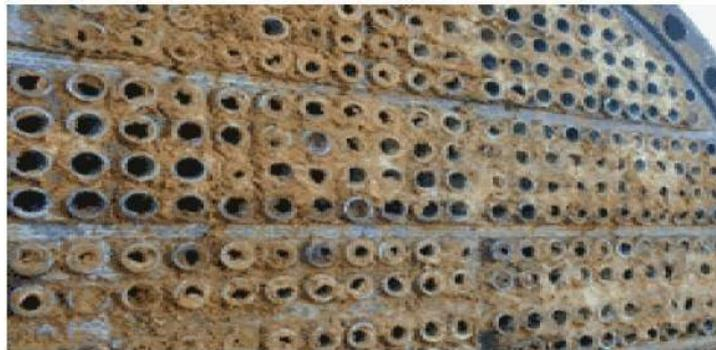
**Figure II.8.** L'encrassement dans un échangeur tubulaire.
