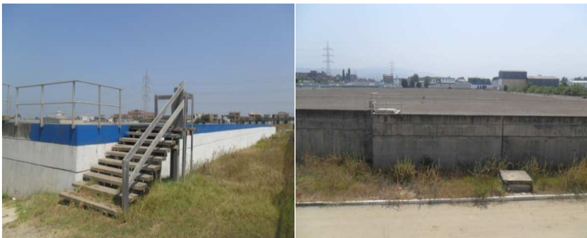
Figure IV.2 - Images réelles du réservoir.
