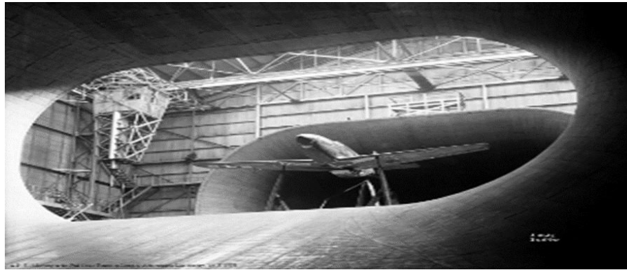
Figure I.3 : Essai à Langley du P51 Mustang [10]
