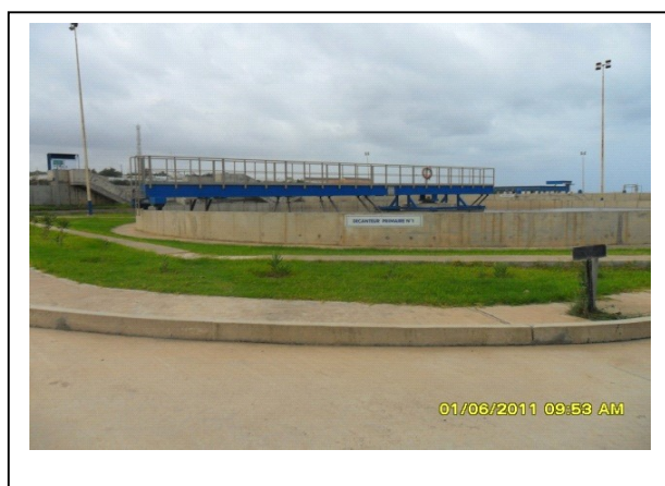
Photo I.4 : Décanteurs primaires de la STEP de Beni-Messous.
