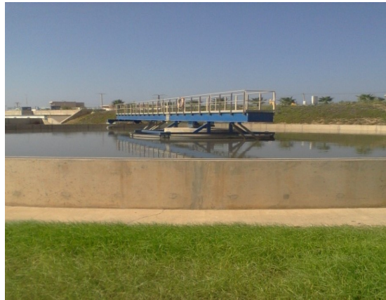
Photo I.5 : Décanteur secondaire de la STEP de Beni-Messous.
