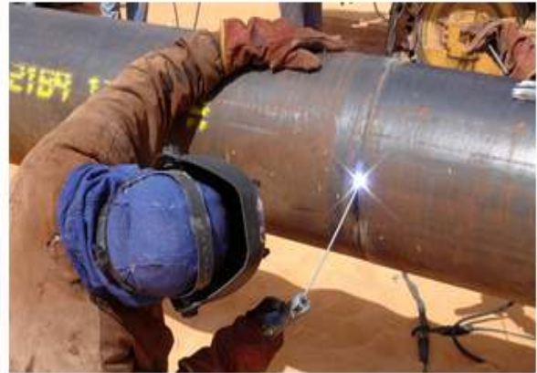
Soudage à l'arc électrique tube de pipeline
