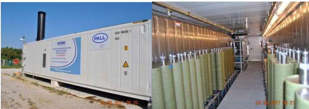
**Photo10** : La station d'épuration unité mobile d'osmose inverse [19].
