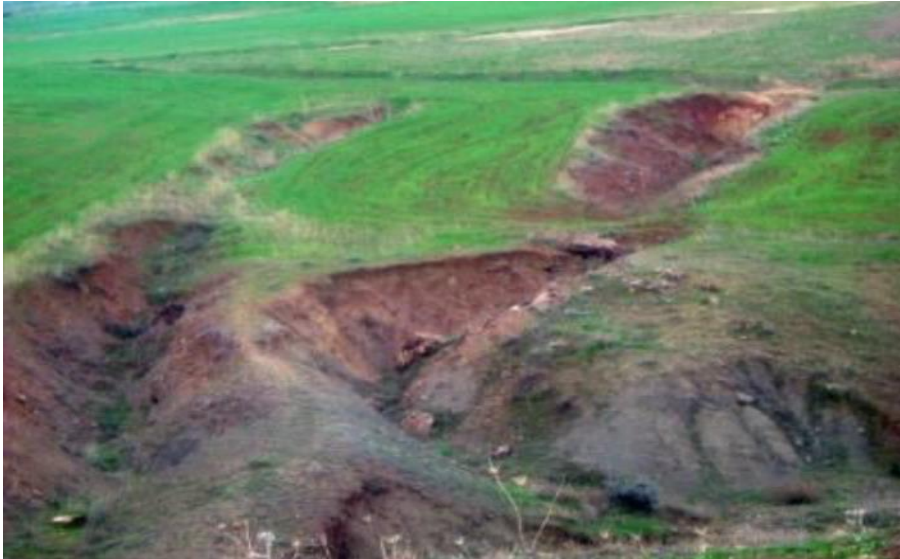
Figure II.4 : Formation d'une ravine au niveau du bassin versant d'Oued Fodda (cliché : Rimini, 2008)
