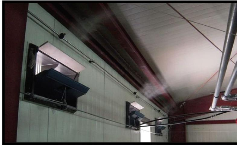
**Figure n °7** : Exemple du système de nébulisation
