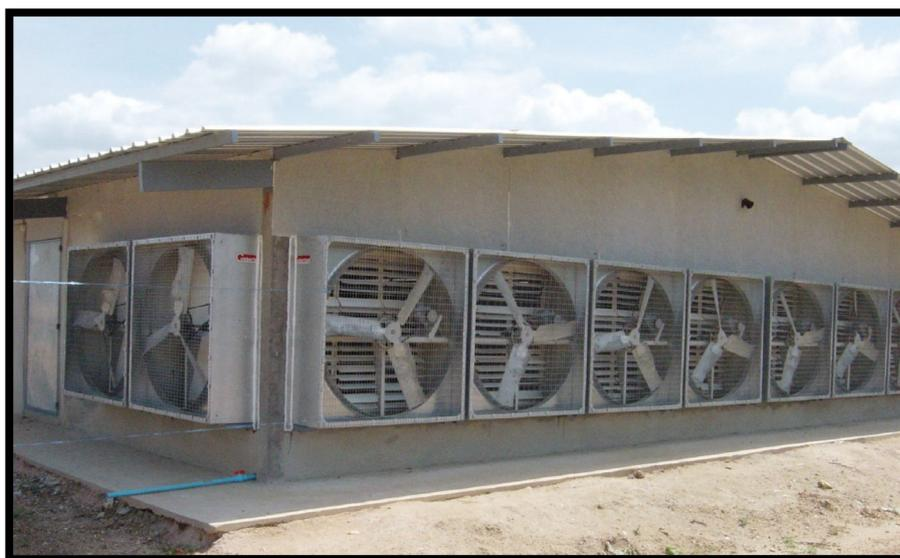
**Figure n°5 : Exemple de ventilation dynamique**
