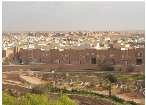
Figure 146: photo de la cité tafilalet. Source : l'auteur durant la visite de site
