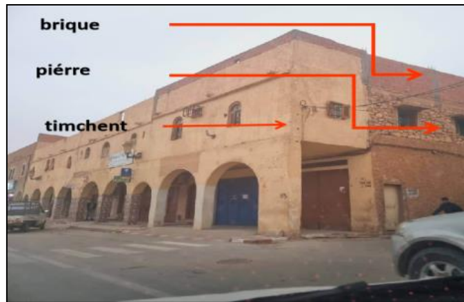
Figure 232: photo des matériaux sur la façade. Source : prise par l'auteur
