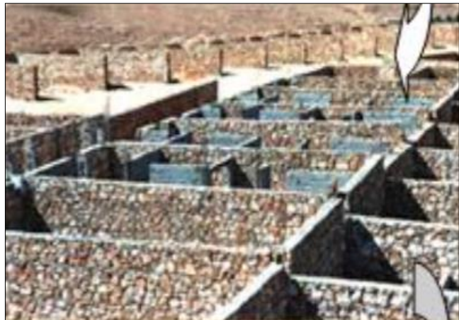
Figure 168: photo de chantier du ksar tafilalet. Source : fondation amidoule.
