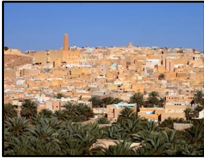
Figure 92 : Ksar el Atteuf source : OPVM
