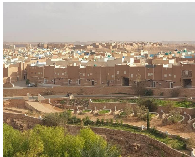
Figure 147: photo de la cité Tafilalet. Source : l'auteur durant la visite de site
