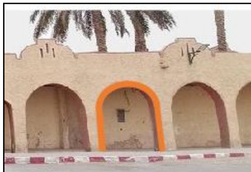
Figure 233: arc plein cintre pour l'ensemble des galeries. Source : prise par l'auteur
