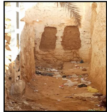
Figure 188 : les ouvertures aux pieds des murs de clôture.
