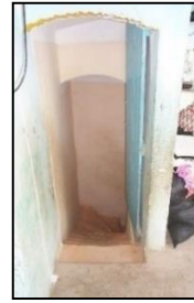
Figure 156: photo de l'escalier par l'auteur
