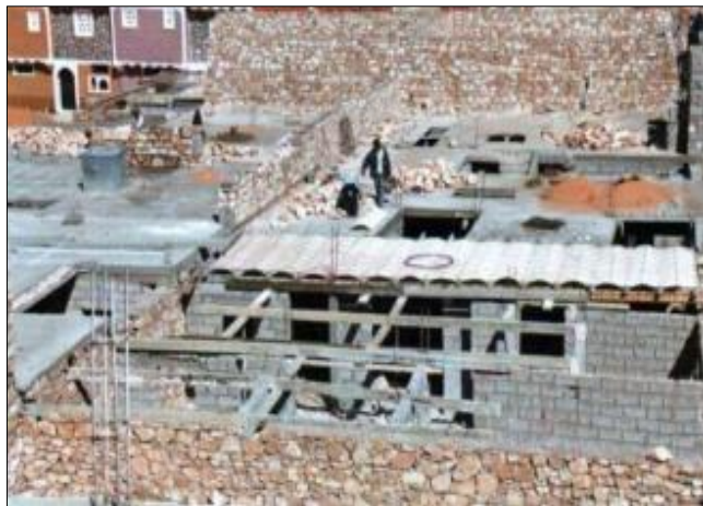
Figure 140 : photo de chantier de ksar tafilalet. Source: fondation amidoule.
