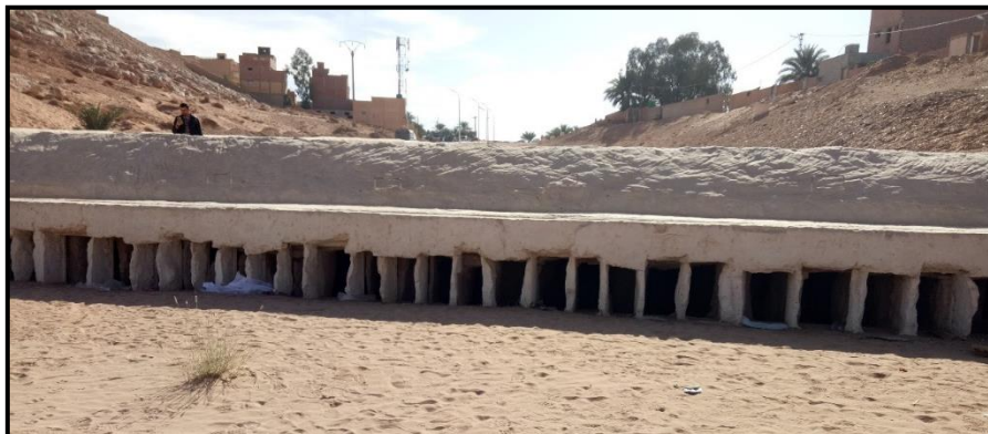
Figure 187: les canaux de récupération et drainage d'eau. Source : auteur durant la visite du site
