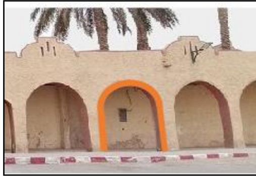
Figure 203: arc plein cintre pour l'ensemble des galeries. Source : prise par l'auteur
