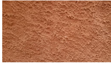
Figure 168: photo de timchemt. Source: l'auteur durant la visite du site
