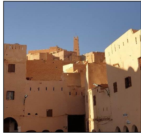
Figure 2 : Photo d'un bâtiment en pierre de ksar el atteuf source : www.OPVM.com
