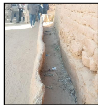
Figure 189 : segua de distribution d'eau. Source: l'auteur durant la visite de site
