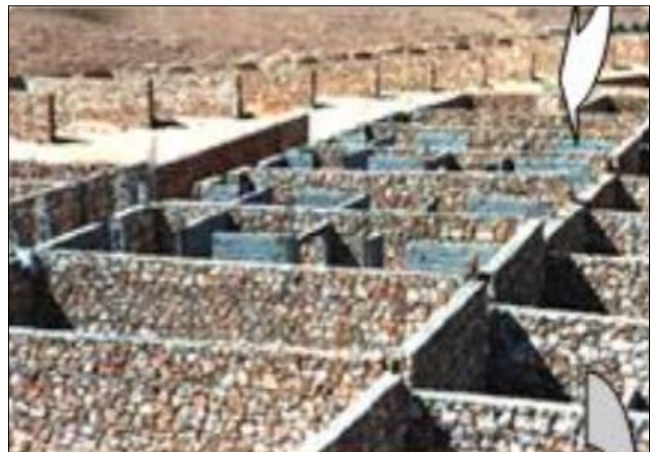
Figure 139: photo de chantier du ksar tafilalet. source: fondation amidoule.
