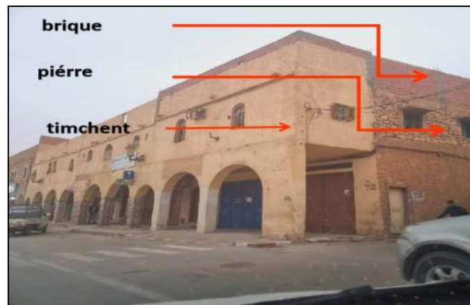
Figure 202: photo des matériaux sur la facade. Source : prise par l'auteur
