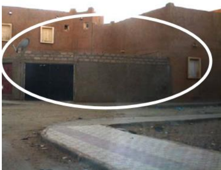
Figure 70 : Extension non réglementaire et agrandissement de la cour, Al Jazira
