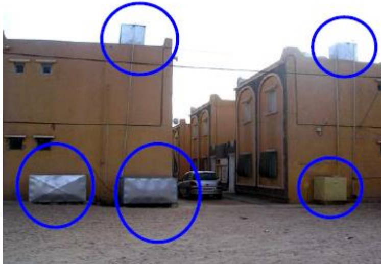
Figure 71 : Installations d'eau aléatoires, Tafsit
