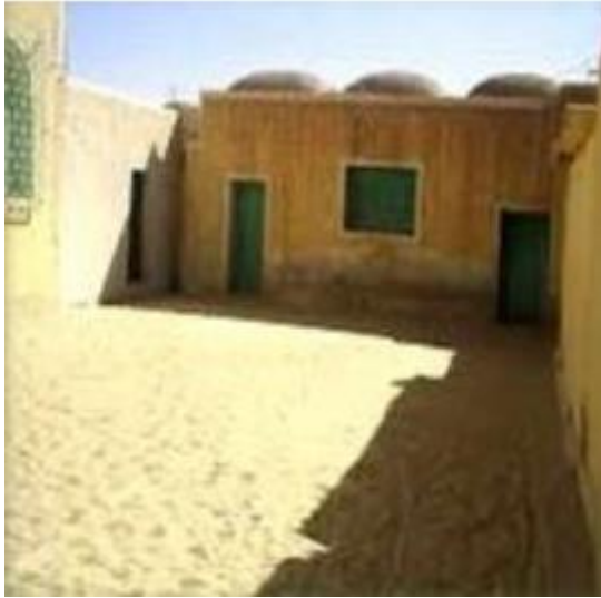
Figure 13 : La maison du soufi
