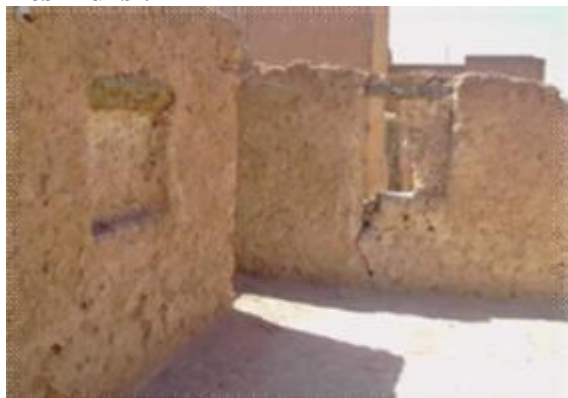
Figure 115 : Photo des murs intérieurs à l'étage d'une maison traditionnelle à El-Ksar Source :
