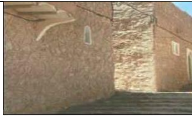
Figure 65 : façade d'une maison ksar tinmirine.
