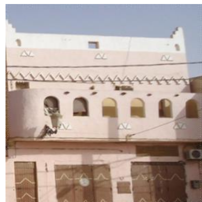
Figure : maison rénovée. Source : auteurs 2023.
