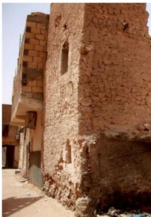
Figure 04 : ksar à Ouargla l'un des exemples de l'architecture traditionnel en Algérie
