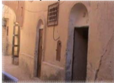
Figure 117 : Photo des murs extérieurs d'une maison / source : http://dSPACE.univ-setif.dz:8888/jspui/
