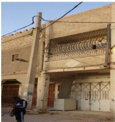
Figure 108 : Maison rénovée Source : auteurs 2023.
