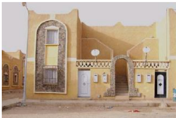
Figure 67 : projet de logements sociaux en cours
