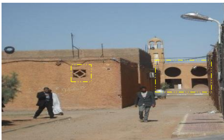
Figure 41 : Les fenêtres aux dimensions réduites.
