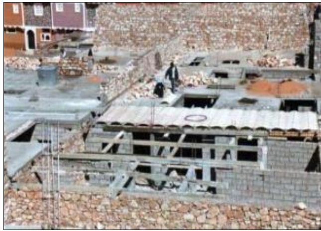
Figure 131: photo de chantier de ksar tafilalet. Source: fondation amidoule.
