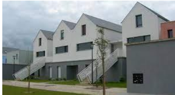
Figure 3 photo d'habitat semi collectif. . source: Google.
