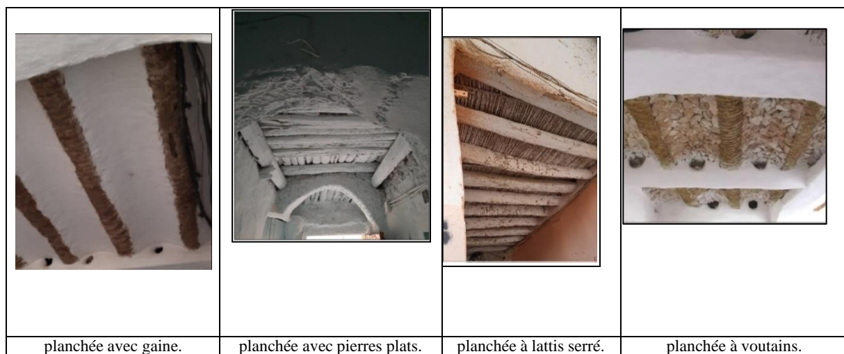
Figure 165: photo des planchers prise par l'auteur.
