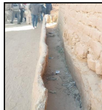
Figure 180: seguia de distribution d'eau. Source: l'auteur durant la visite de site
