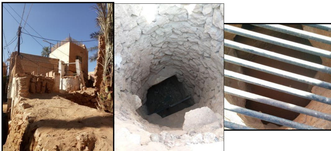
Figure 177: les puits d'irrigation de la palmeraie. Source : auteur durant la visite du site
