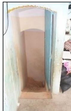
Figure 147: photo de l'escalier par l'auteur
