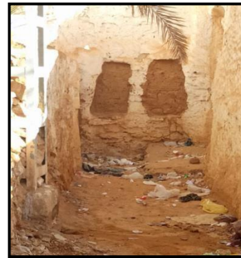
Figure 179: les ouvertures aux pieds des murs de clôture. Source : auteur durant la visite du site
