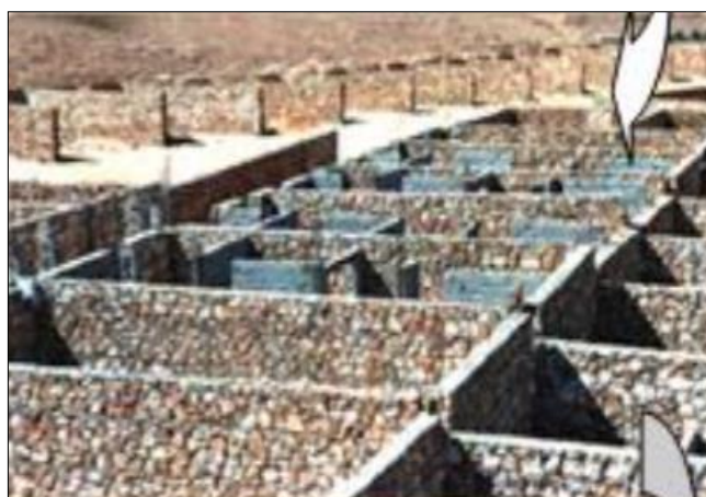
Figure 130: photo de chantier du ksar tafilalet. source: fondation amidoule.
