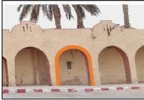
Figure 194: arc plein cintre pour l'ensemble des galeries. Source : prise par l'auteur
