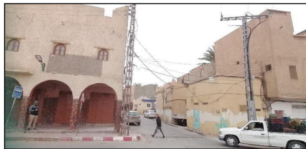
Figure 186: photo des façades dégradées du boulevard. Source : prise par l'auteur
