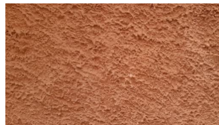
Figure 159: photo de timchemt. Source: l'auteur durant la visite du site
