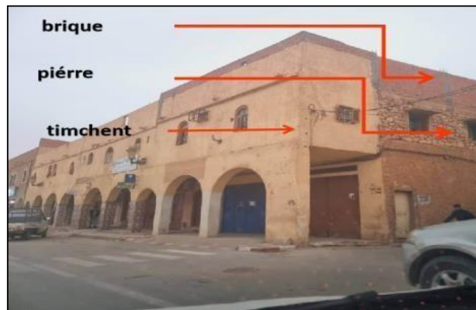
Figure 193: photo des matériaux sur la facade. Source : prise par l'auteur
