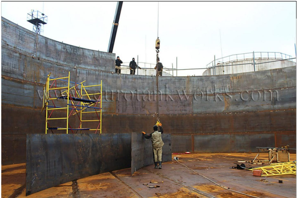
Figure 3.4 : Assemblage de la robe du réservoir (plaque par plaque) [7]
