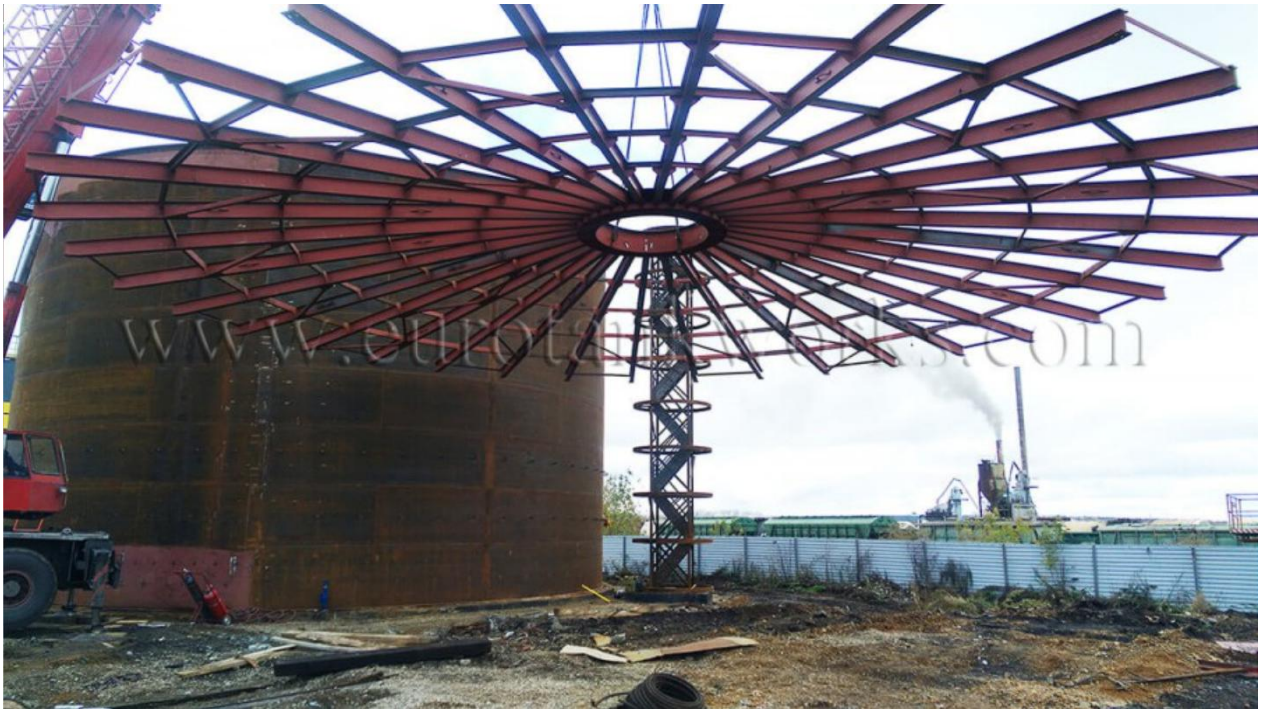
Figure 3.6 : Installation de toits fixes de réservoirs de stockage [7].
