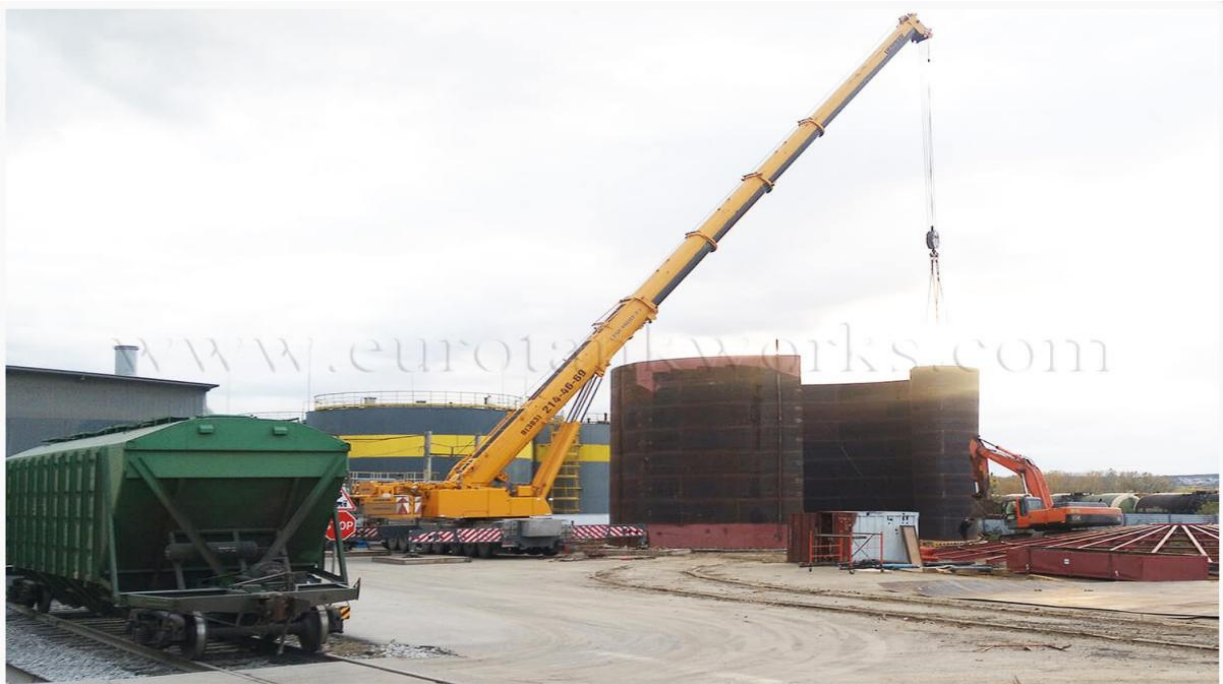
Figure 3.1 : construction de réservoir [7]
