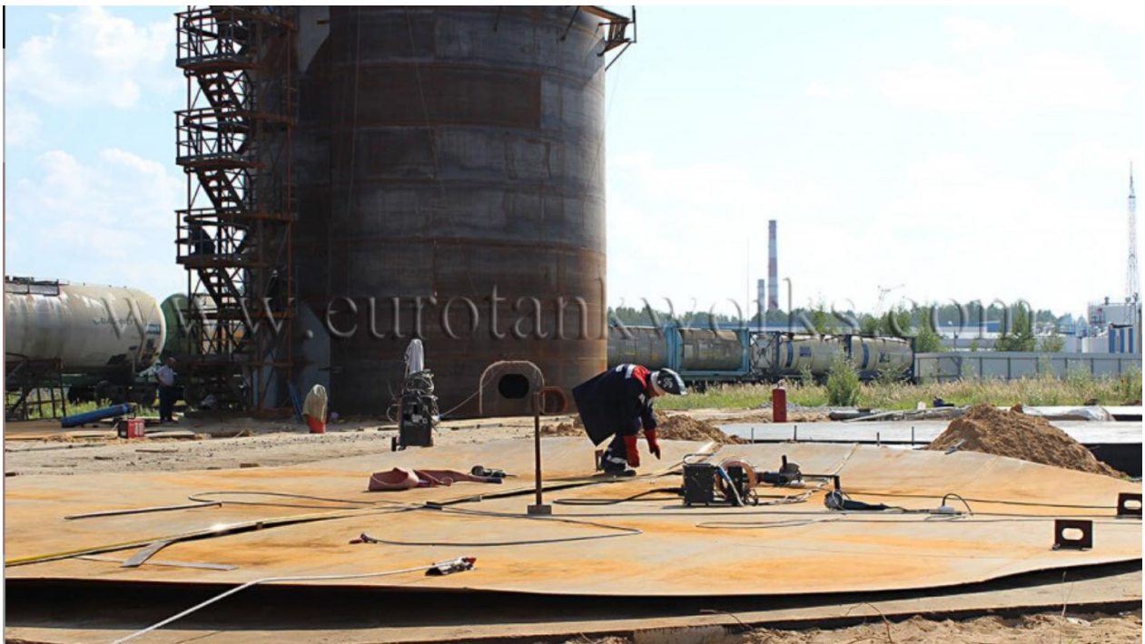
Figure 3.3 : Installation fond du réservoir de stockage. [7]
