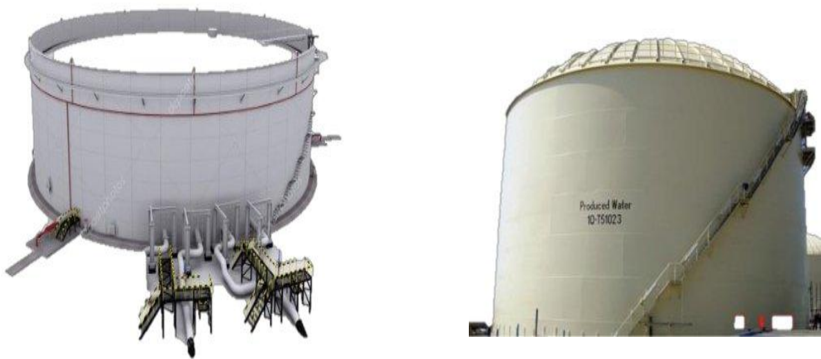
Figure 1.8 : réservoirs de stockage cylindriques verticaux. [2]
