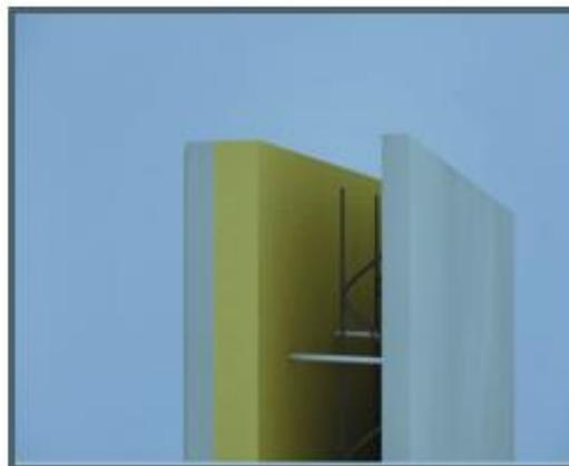
Figure 10 : mur a isolation intégrée.
