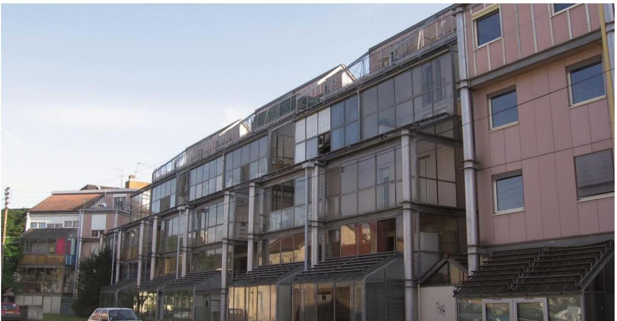
**Figure 1.4** : Les serres sont placées en espace tampon entre l'ambiance extérieure et la paroi des logements, Dijon (arch. Dubosc- Landowski) [8]
