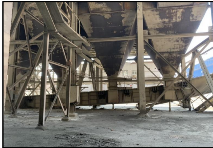
Figure 2-6: Trémies de poussière et chaînes de transport
