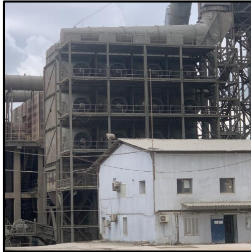
Figure 2-3 : Echangeur air/air SCMI
