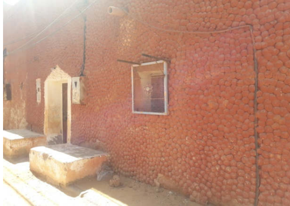
Figure 62 : exemple d'une maison traditionnelle. Source. Zougari.Z
