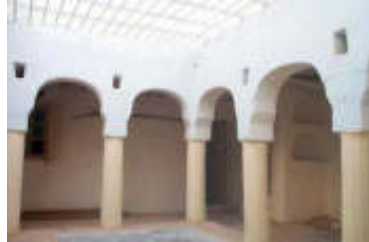
Figure 19: Exemple de Galerie
