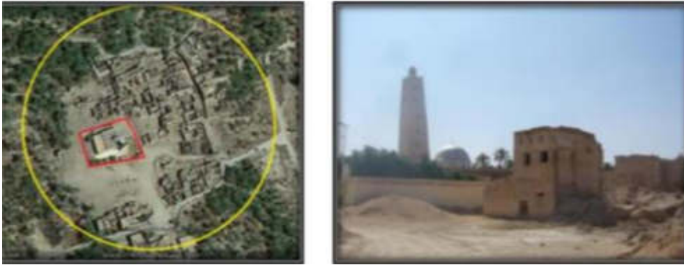
Figure 9 ksar de Farfar avec sa mosquée (yahia ben ahmed),seul édifice intact.
