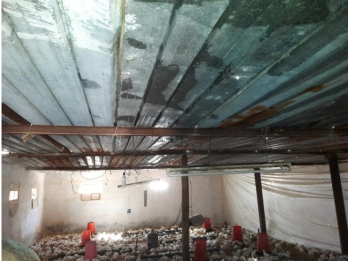
Figure 3 : Toiture en zinc profilée
