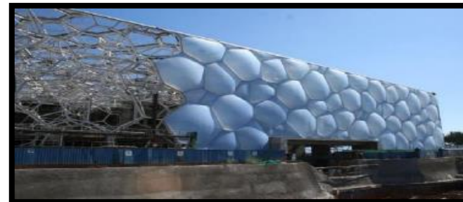
FigII.64 : Façade en cour de construction
