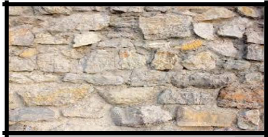
Figure II.45:mur en pierre source :-travaux-maçonnerie.fr
