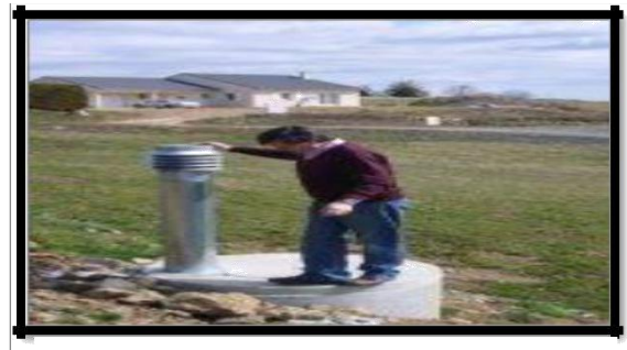
Figure II.51:puits canadien Source : genersys-service.com
