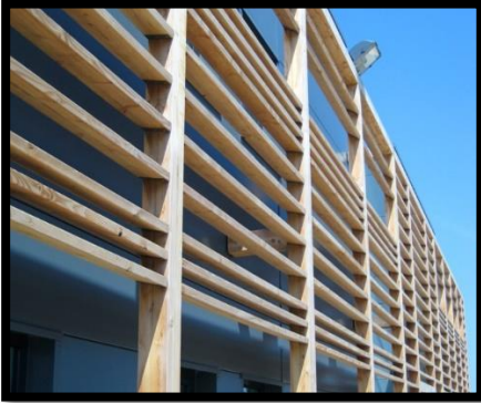
FigII.69 : Façade en double vitrage
