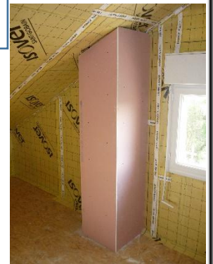
Fig 72. Couverture des poteaux métalliques par Placoplatre
