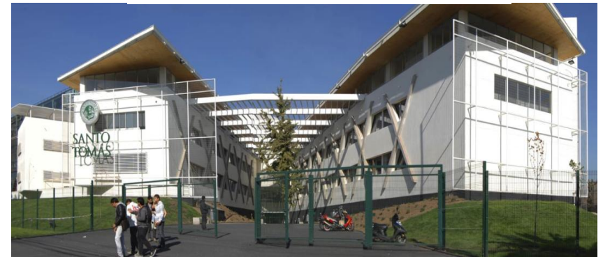
Figure VIII-10 vue extérieure du projet ; source : archdaily
