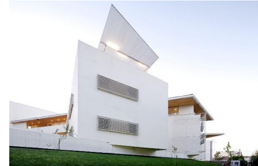
Figure VIII-9 vue extérieure du projet ; source : archdaily
