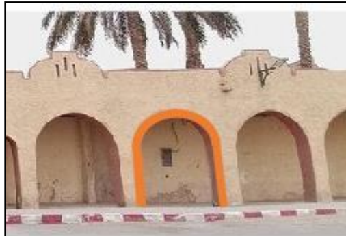
Figure 233: arc plein cintre pour l'ensemble des galeries. Source : prise par l'auteur
