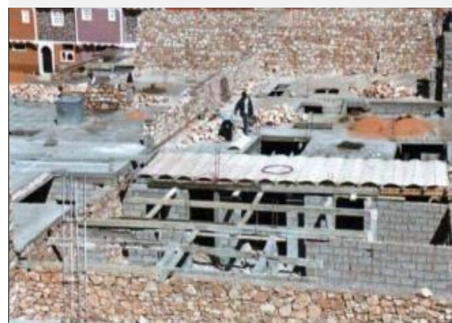
Figure 169: photo de chantier de ksar tafilalet. Source: fondation amidoul.
