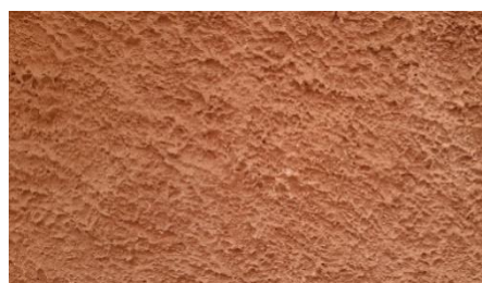
Figure 197: photo de timchemt. Source : l'auteur durant la visite du site
