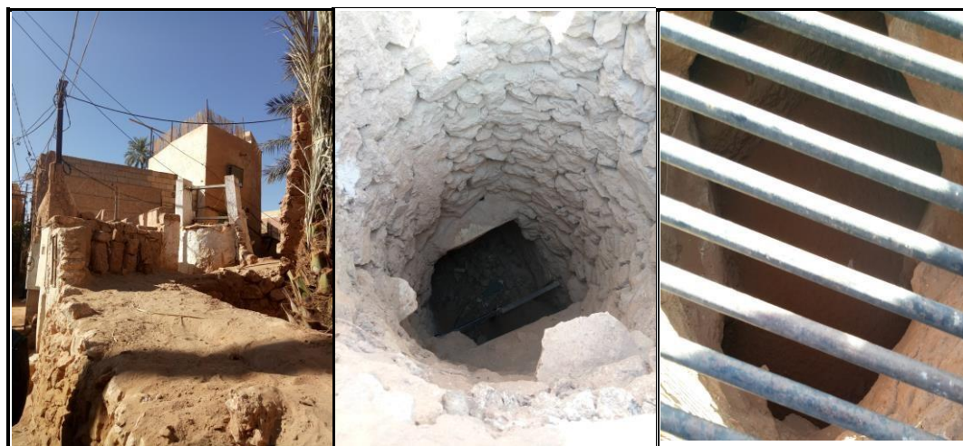
Figure 215: les puits d'irrigation de la palmeraie. Source : auteur durant la visite du site
