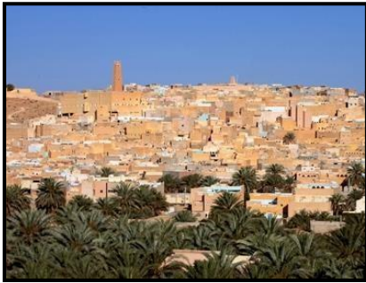
Figure 92 : Ksar el Atteuf source : OPVM
