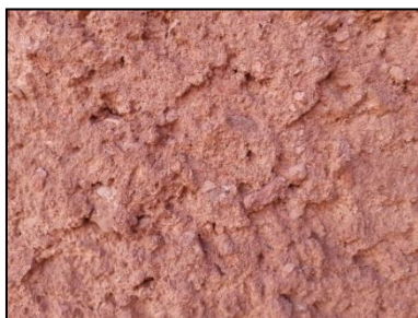
Figure 194: la pierre photo prise par l'auteur durant la visite du site.
