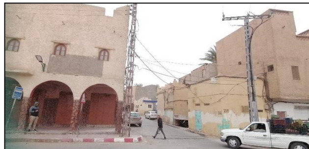
Figure 224: photo des façades dégradé du boulevard. Source : prise par l'auteur
