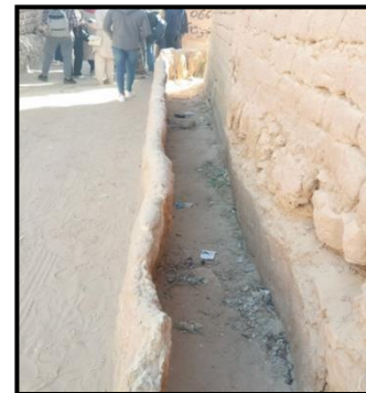
Figure 218: seguia de distribution d'eau. Source : l'auteur durant la visite de site
