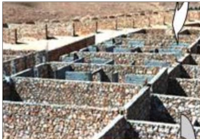
Figure 168: photo de chantier du ksar tafilalet. Source : fondation amidoul.
