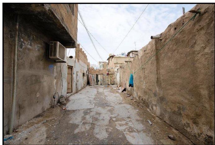
Figure 48: Ruelle de l'ancien souk waqif avant la restructuration , Source : Google photos
