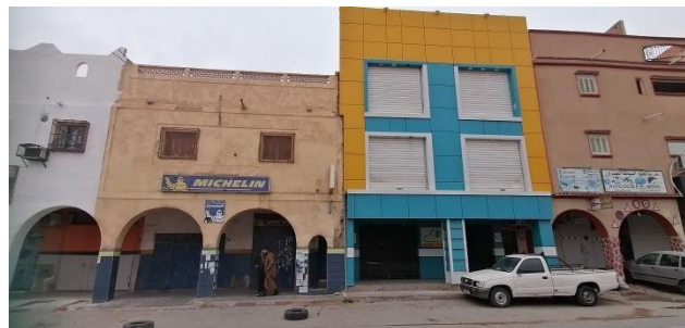
Figure 225: façade sur le boulevard 5 juillet. Source : prise par l'auteur
