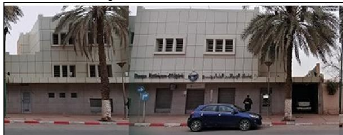
Figure 231: photo d'une façade qui donne sur le boulevard 1 mai. Source : prise par l'auteur
