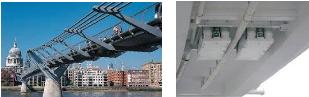
Figure 1-10 : TMDs verticaux installés sous le tablier de la passerelle du Millenium à Londres.
