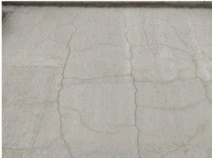
**Figure I.14 :** Fissuration de peau observée sur une dalle en béton armé conservée dans l'air (HR=44% ; T=32°C ; Vitesse de vent=8m/s). Les fissures observées ont une moyenne de 0.22mm [21].
