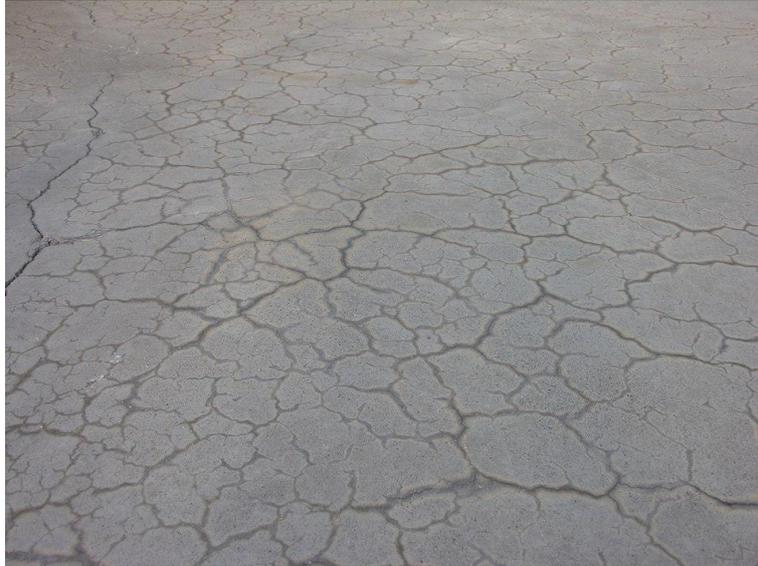
**Figure I.13 :** Réseau de fissures de surface, imputable à l'absence ou l'insuffisance du traitement de cure [23, 24].
