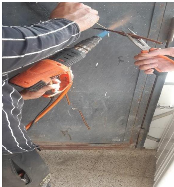
Figure. 4.42 : Soudage de tuyaux en cuivre
