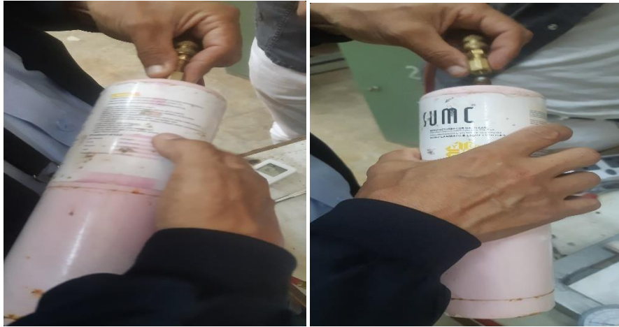
Figure. 4.39 : Remplissage de gaz 410 A
