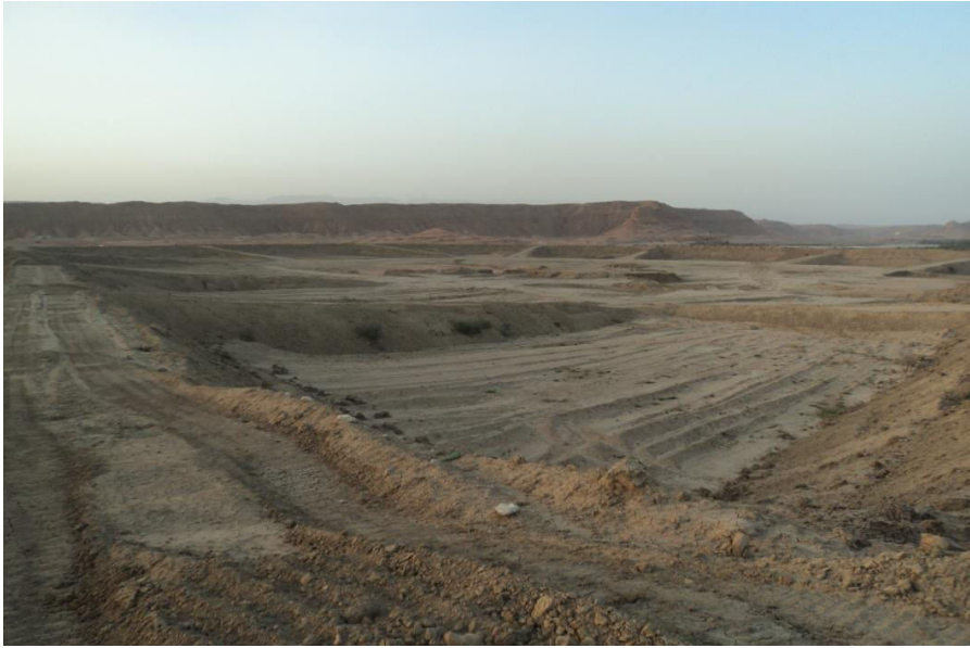
Fig 2.5. Aménagement des bassins de stockage a l'amont de la retenue du barrage de Foum el Gherza.
