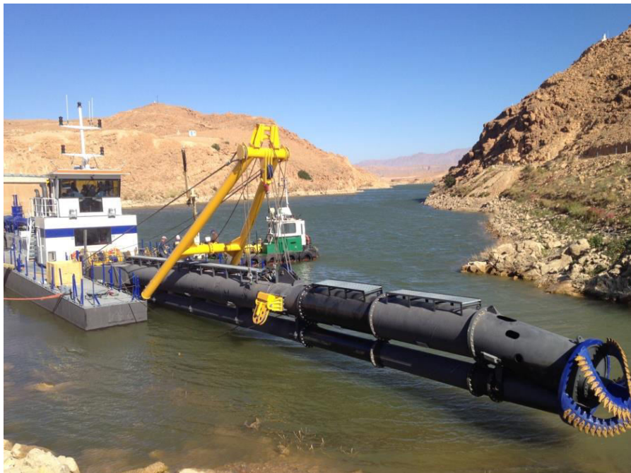
Figure 2.2. La drague hydraulique utilisée lors de l'opération de dragage du barrage de Foum el Gherza.
