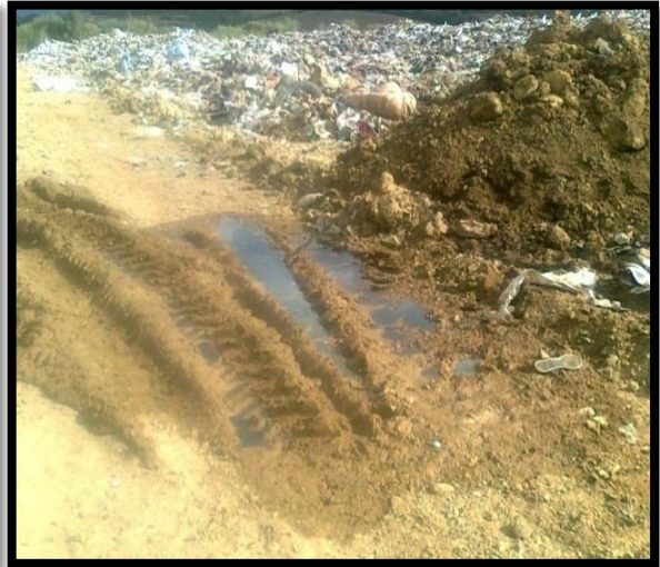
Fig21 : les fuites des digues.
