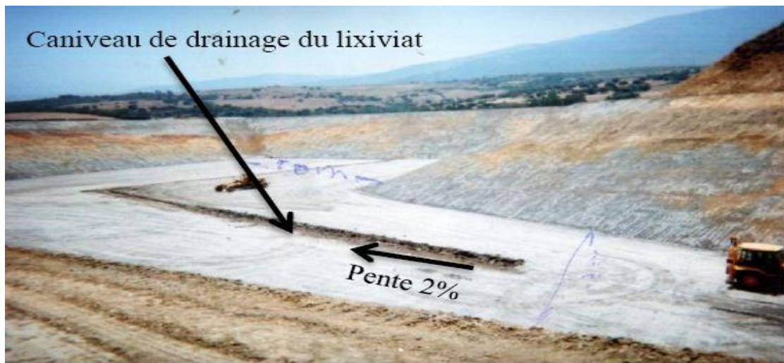
Fig.16 : Caniveau de drainage du lixiviat
