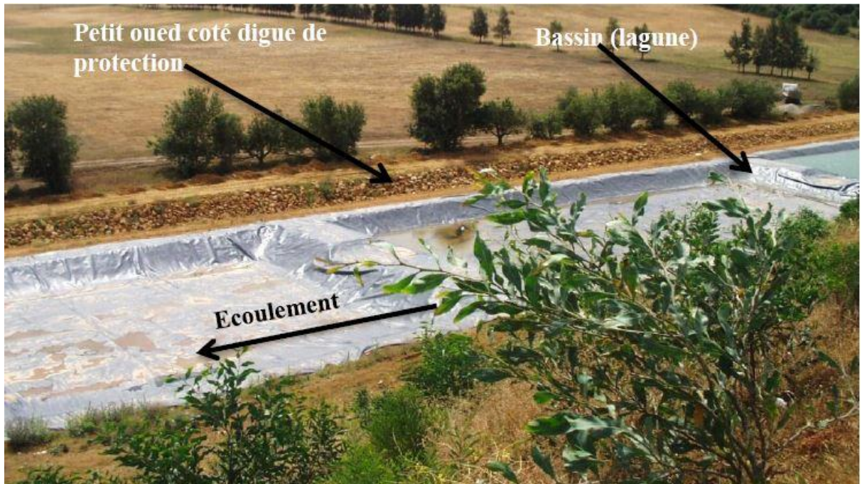
Fig.17. Vue des bassins de lagunage avant [42]
