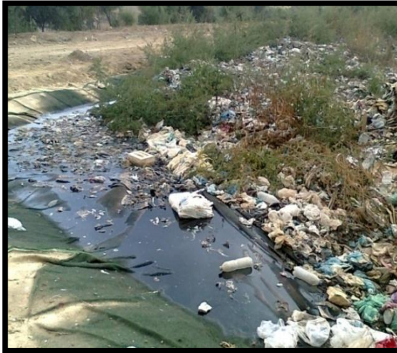
Fig 20 : l'accumulation des lixiviats dans le casier.
