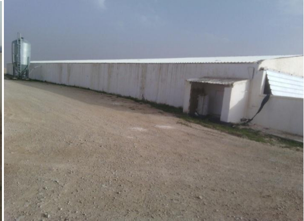
Photo n°02 : vue de profile des bâtiments.
