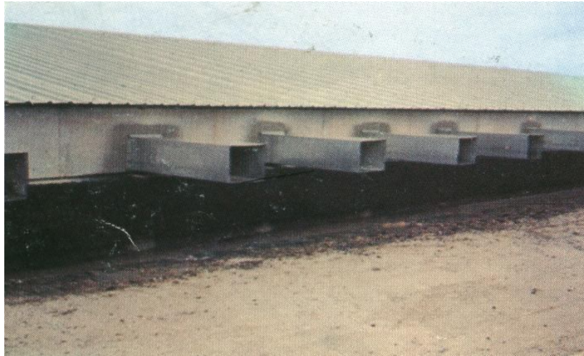
Figure 10 : Orifice à ventilation dans un poulailler à ventilation mécanique.
