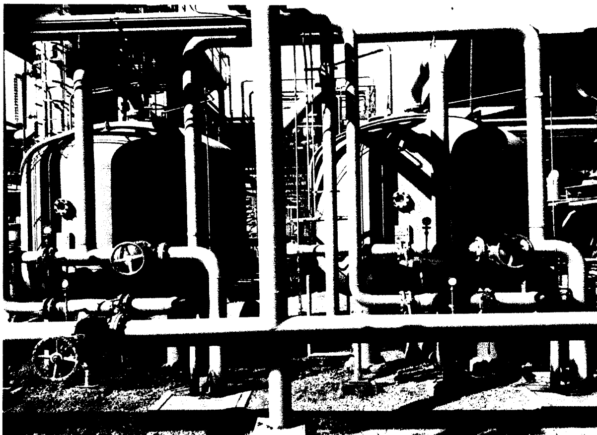
Fig. N° 8 : Les deux filtres à sable.
