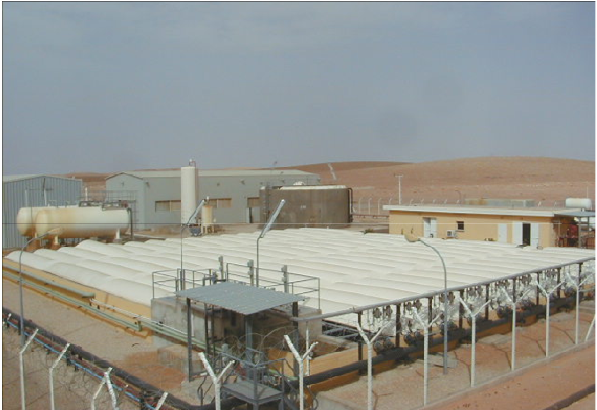
VUE GENERALE DE L'UNITE DE TRAITEMENT DES EAUX HUILEUSES
