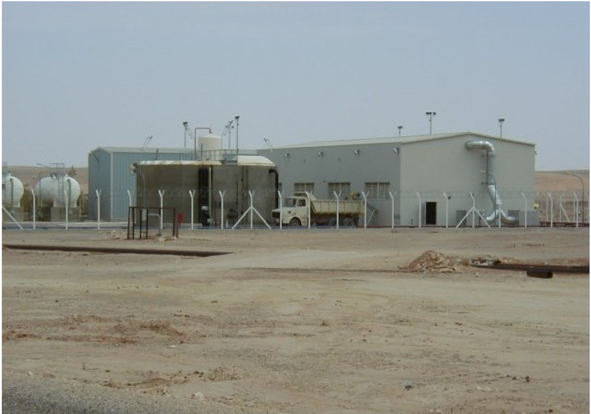
VUE GENERALE DE L'UNITE DE TRAITEMENT DES EAUX HUILEUSES
