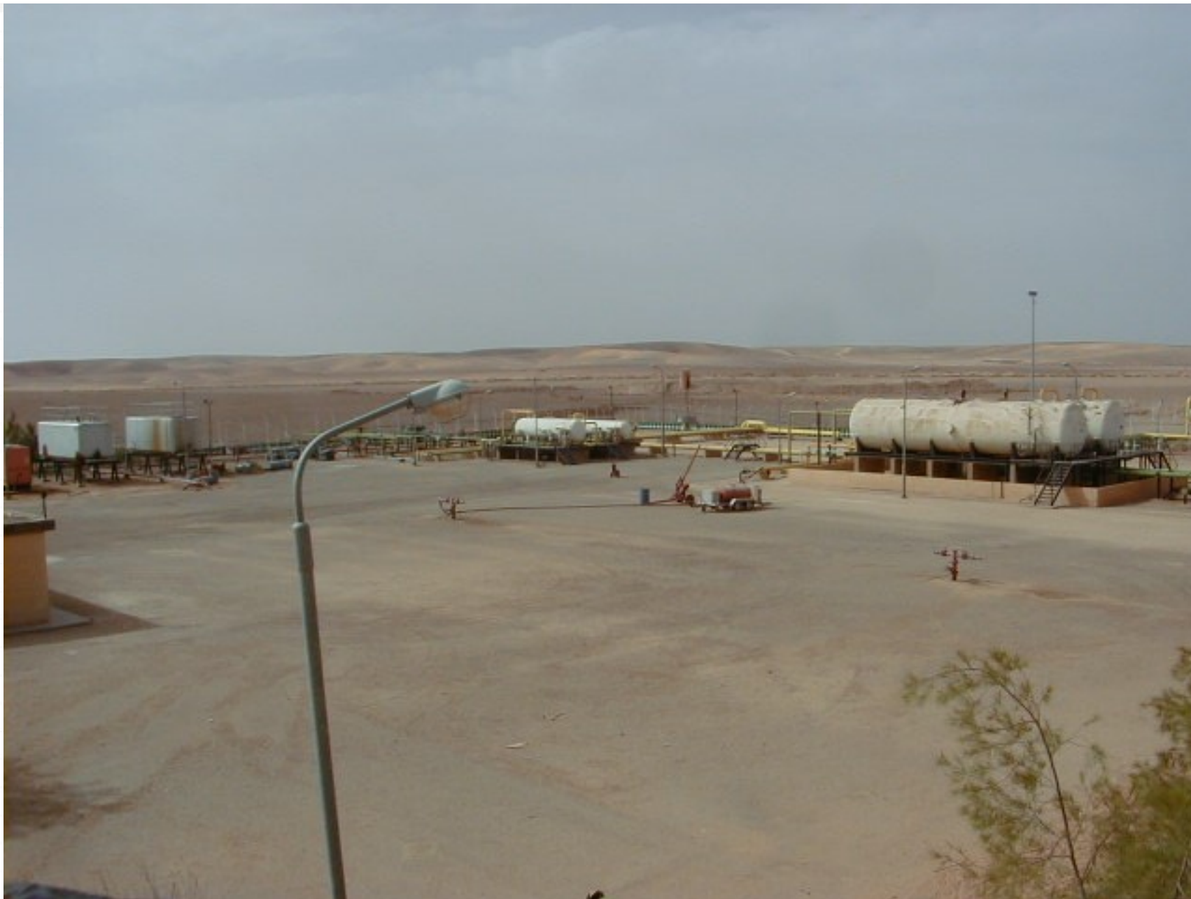
HASSI R'MEL : VUE GENERALE D'UN C.T.H
