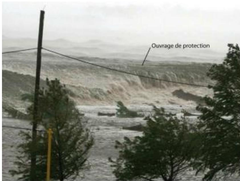
Figure 50: Illustration d'une submersion par débordement pendant le cyclone Katrina dans le Golfe du Mexique aux USA. Crédit photo : NOAA. Source : In (Breilh, 2004, p.14)
