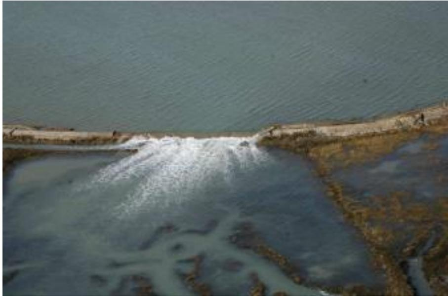
Figure 51: phénomène de submersion par rupture d'un ouvrage de protection suite à la tempête Xynthia. Source: (Breilh, 2014).
