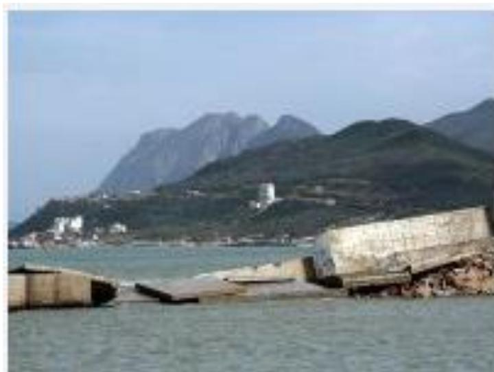
Figure 75: la digue du port de Béjaïa fracturé par la houle en 2013. Source: <https://www.algerie360.com/la-digue-de-protection-du-port-de-peche-de-tala-ilef-bejaia-fracturee-par-la-houle/>
