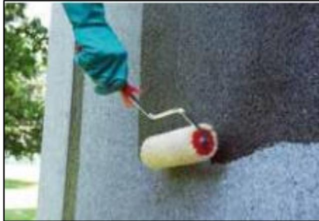
Figure I. 15 Application d'hydrofuges de surface
