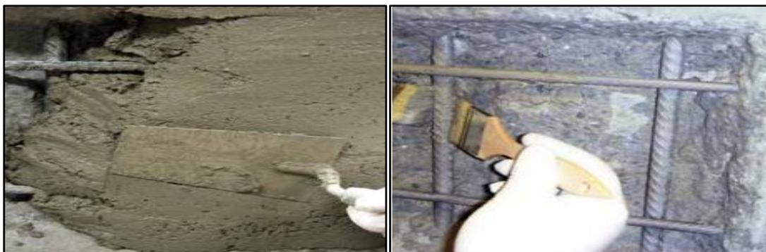
Figure I.13 Ragréage après traitement de corrosion des armatures
