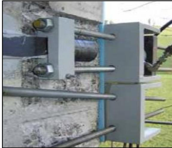
Figure I.19 Application d'une précontrainte additionnelle extérieure [30]
