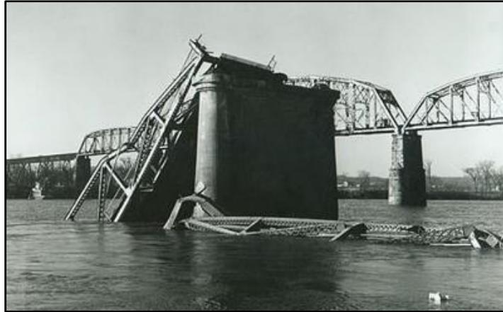
Figure I.6 Vue de l'effondrement du pont "Silver Bridge"
