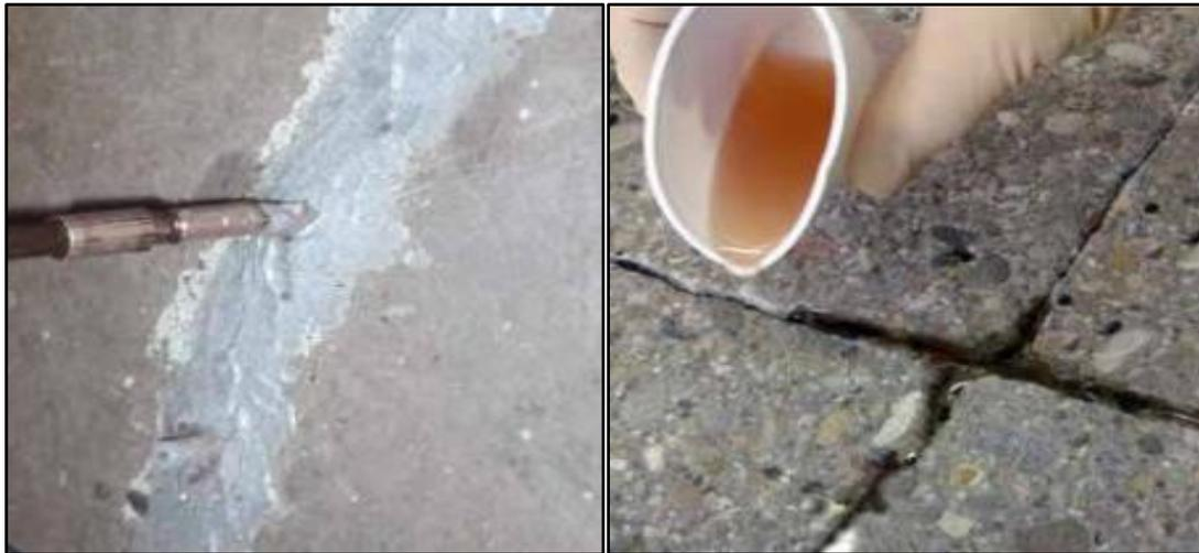
Figure I.14 Mécanisme d'injection des fissures
