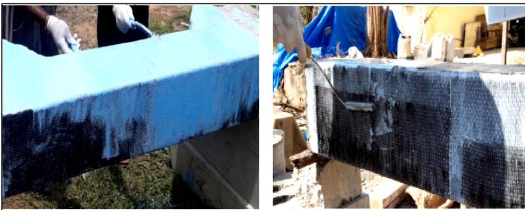
Figure I.25 Renforcement par Collage Externe des FRP [40]
