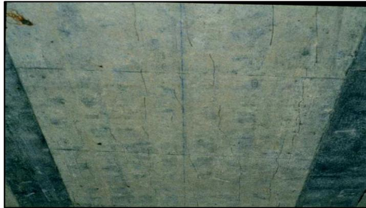
Figure I.10 Vue de fissures dues au retrait au béton
