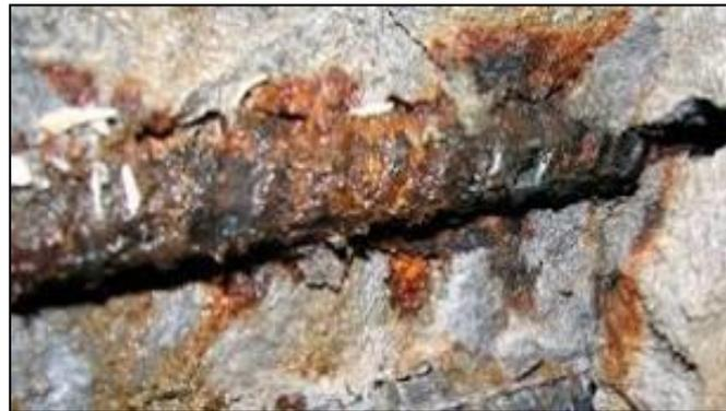
Figure I.12 Corrosion avancée de l'armature HA [29]
