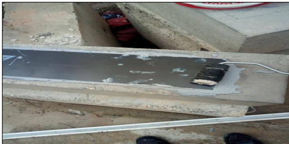
Figure II.27 Placage de la lamelle Sika Carbodur sur le support béton
