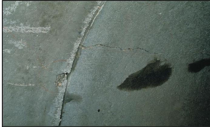
Figure I.7 Vue de fissuration du béton [24]
