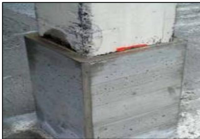
Figure I.16 Pose de mortier pour assurer l'enrobage
