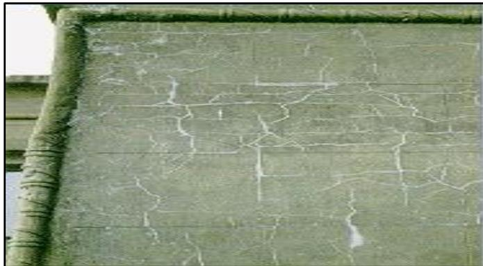
Figure I.8 Faïençage du béton [25]
