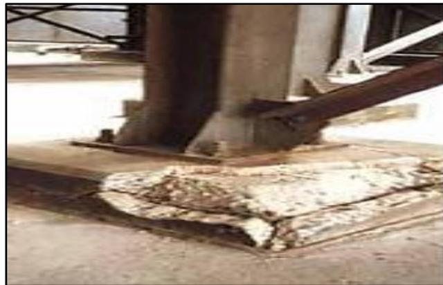
Figure I.9 Eclatement du béton due à un choc [28]
