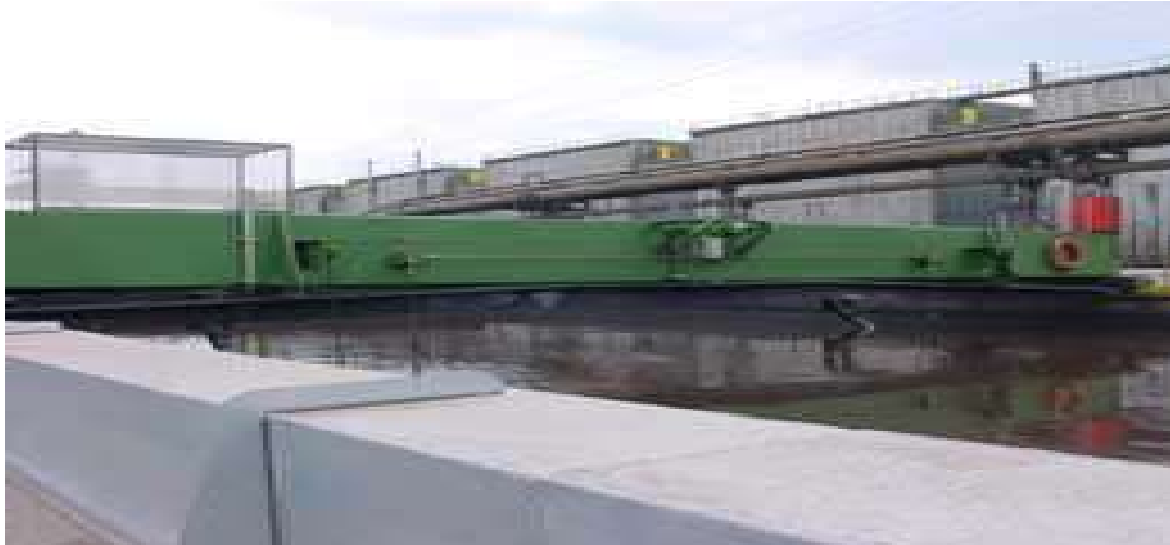
Figure III6 : Décanteur rectangulaire
